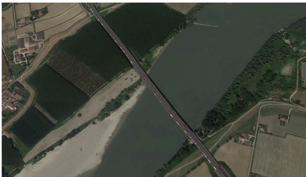
FIG. 7 – IMMAGINE AEREA DEL PONTE DELL’A22 SUL FIUME PO (DA GOOGLE EARTH)
