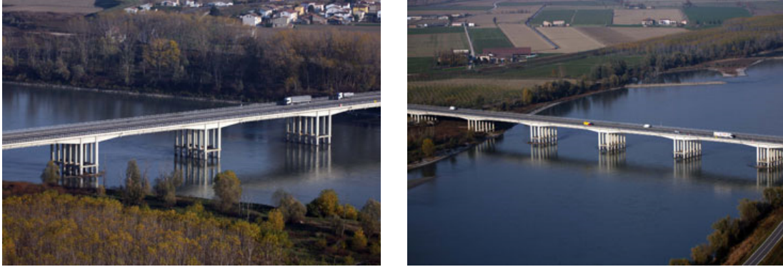
Figura 1.1 - Autostrada A22 del Brennero, viadotto sul Fiume Po, viste da Ovest -
