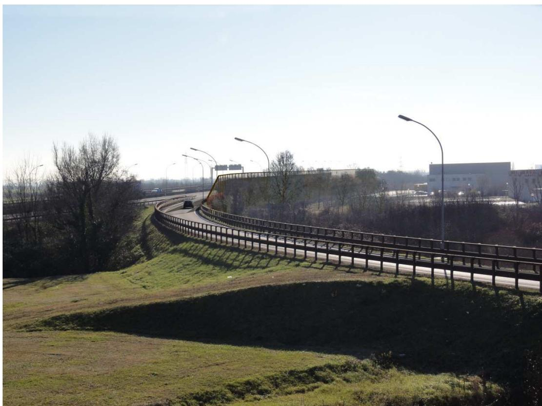
Figura 57: Intervento di mascheramento dell'allargamento di tipo D con barriera antirumore presso lo svincolo di Mantova nord – stato invernale
