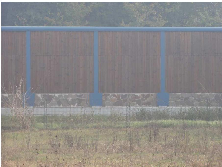
**Figura 47: Barriera antirumore esistente con fondazione in cemento a vista e una parte con finitura a roccia, travi di sostegno dei pannelli colorati in blu.**
