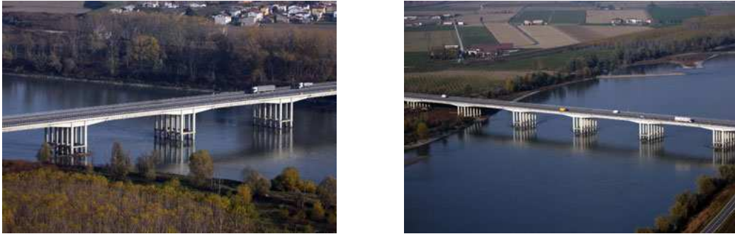
Figura 4 – Ponte autostradale sul fiume Po visto da Ovest
