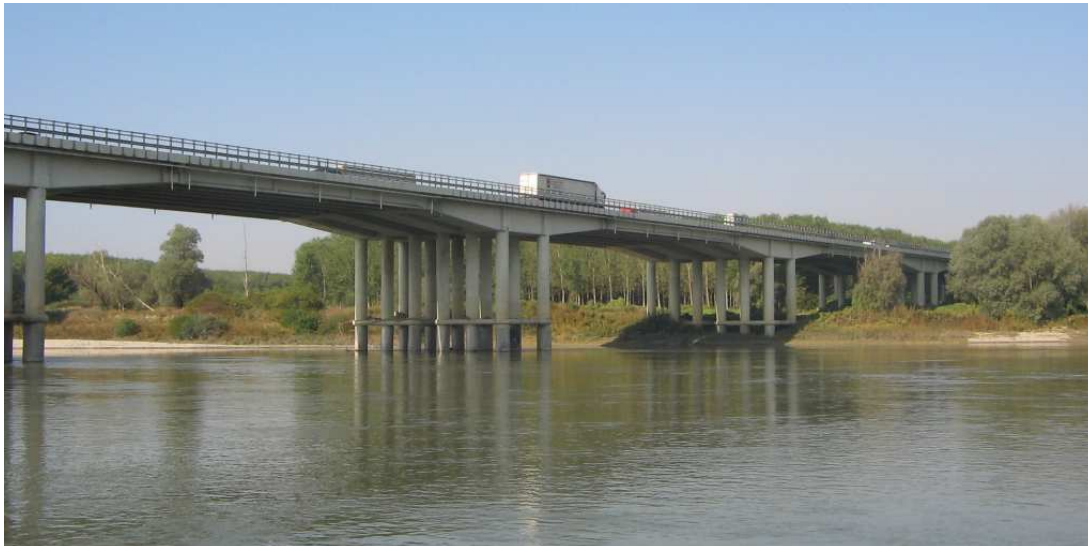
Figura 2 – Ponte Autostradale A22 sul fiume Po visto da valle
