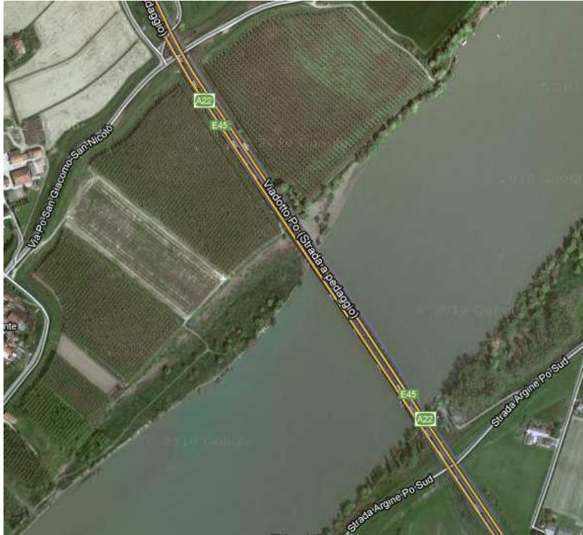
Figura 1 – Vista aerea del viadotto Autostradale A22 sul fiume Po nei pressi di San Nicolò Po
