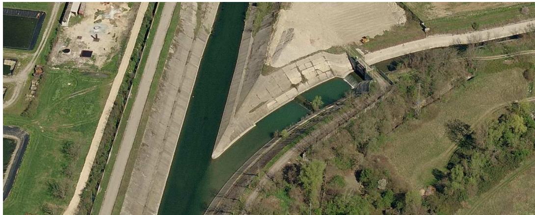
Figura 10 - Foto aerea del salto di fondo nel tratto a valle del Canale Acque Alte (fonte: Bing Maps)
