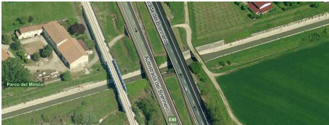
Figura 11 - Foto aerea del tratto di Canale Acque Alte in corrispondenza dell'attraversamento autostradale (fonte: Bing Maps)
