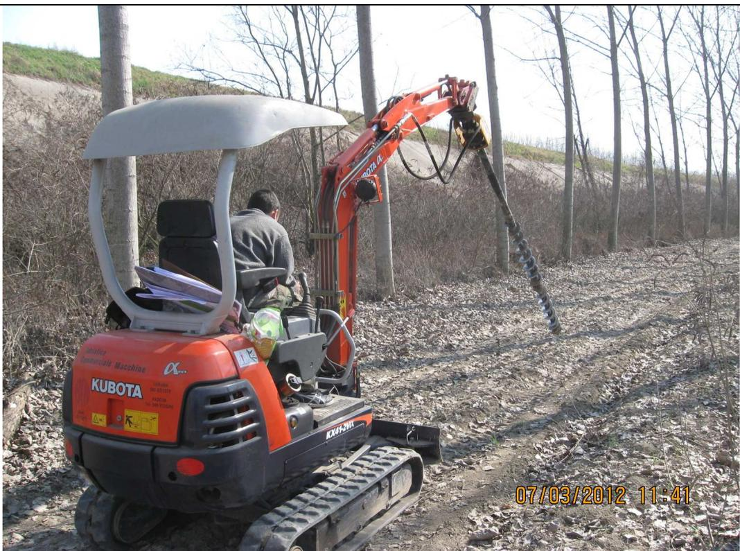
*Fig. 1: il tratto di argine da sistemare con il mezzo utilizzato per le trivellazioni*
