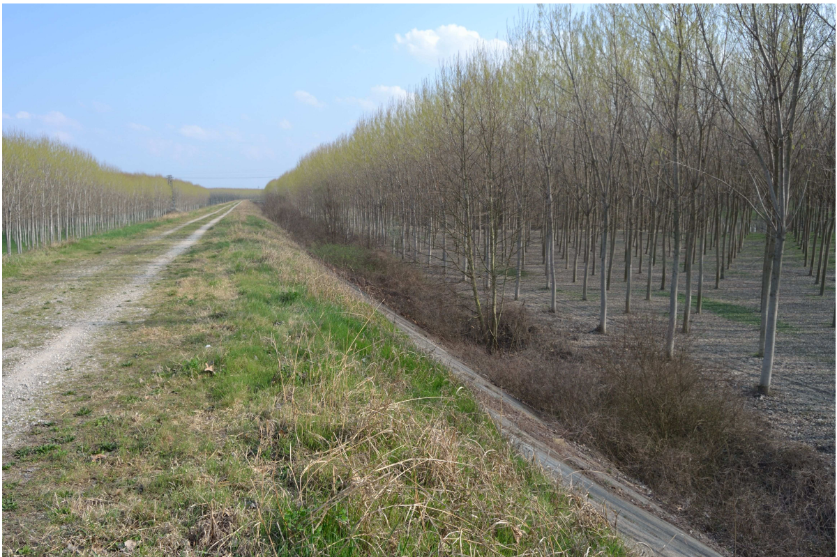
Figura 4: Punto di osservazione 3: vista della scarpata dell'argine dalla sommità dell'opera
