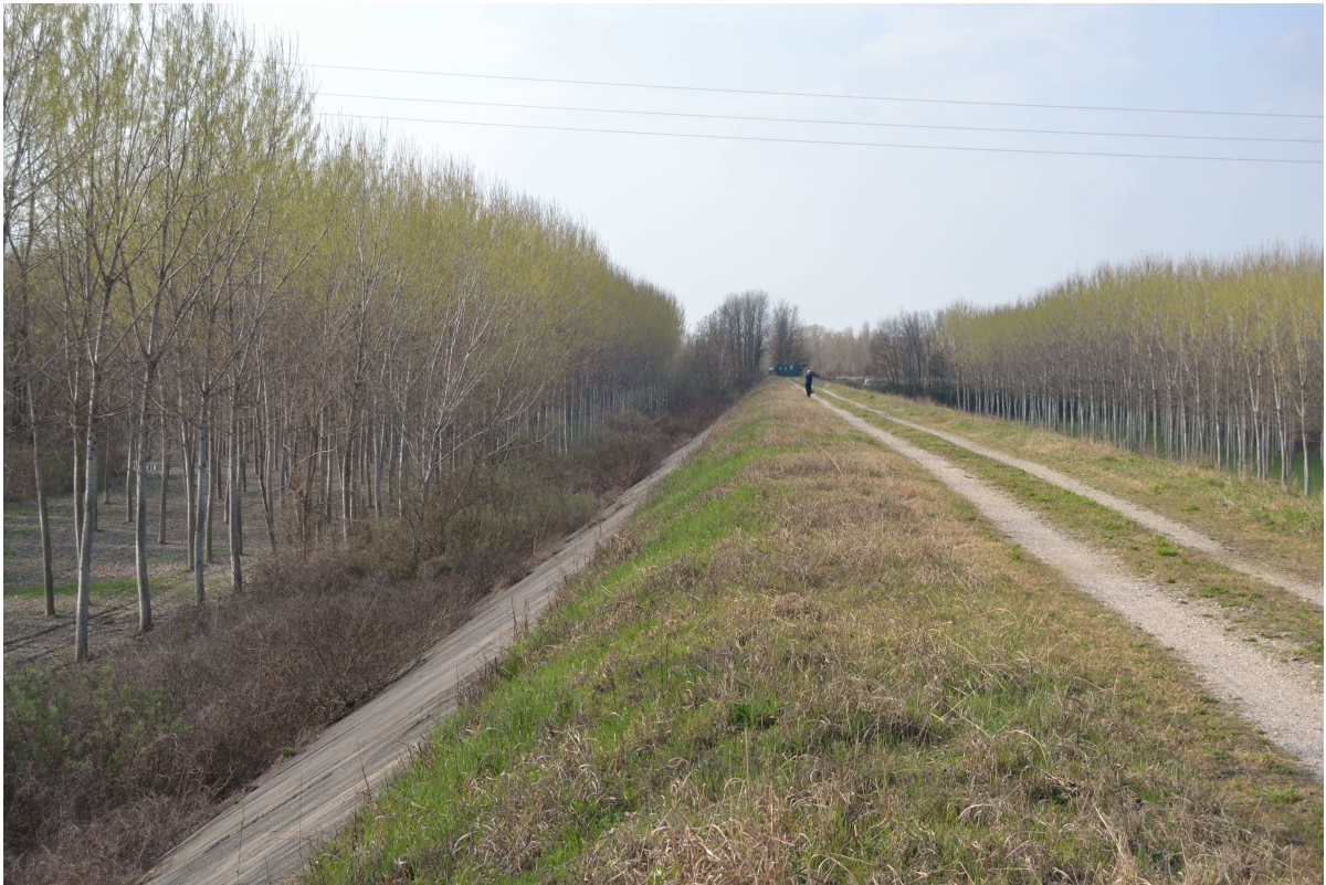
Figura 3: Punto di osservazione 2: vista della scarpata dell'argine dalla sommità dell'opera
