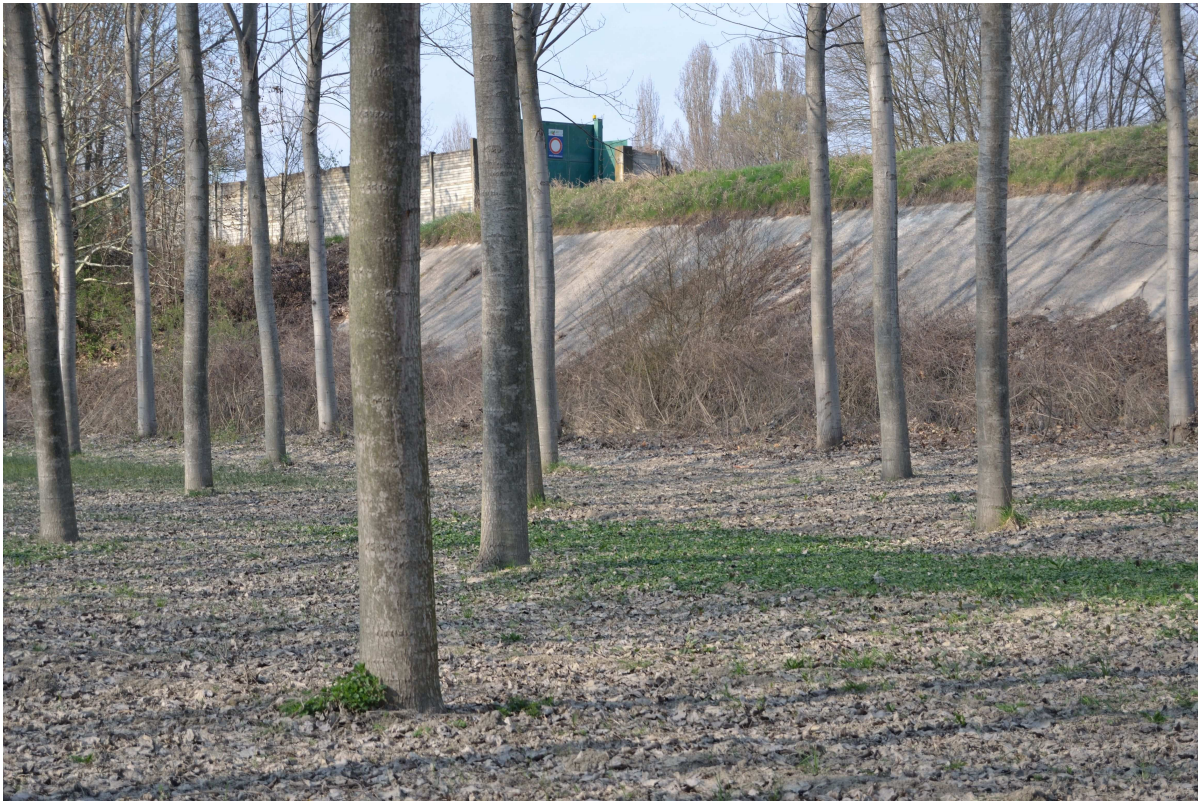
Figura 6: Punto di osservazione 5: vista frontale dell'argine
