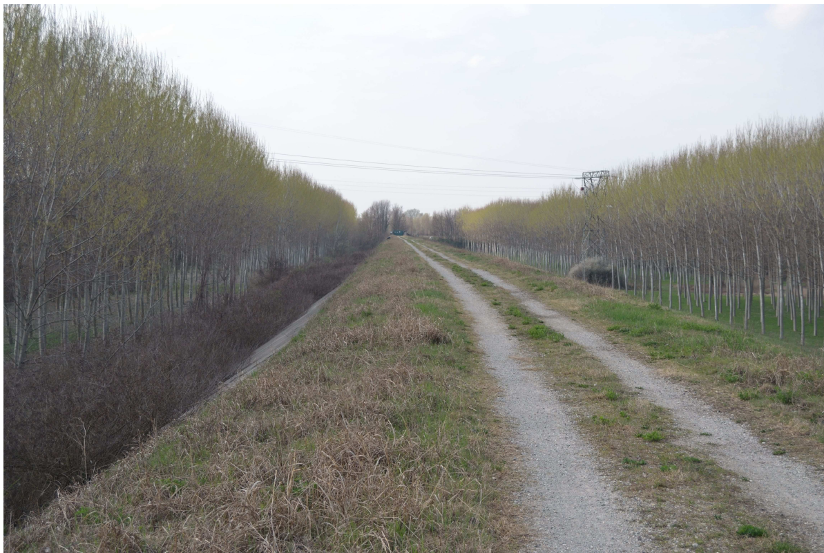
Figura 2: Punto di osservazione 1: vista dalla sommità dell'argine
