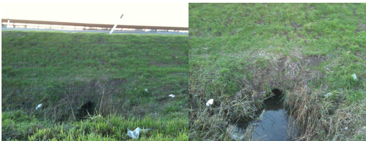
FIGURA 3.4-1 – ATTRAVERSAMENTI IDRAULICI NON IDONEI A FINI FAUNISTICI
