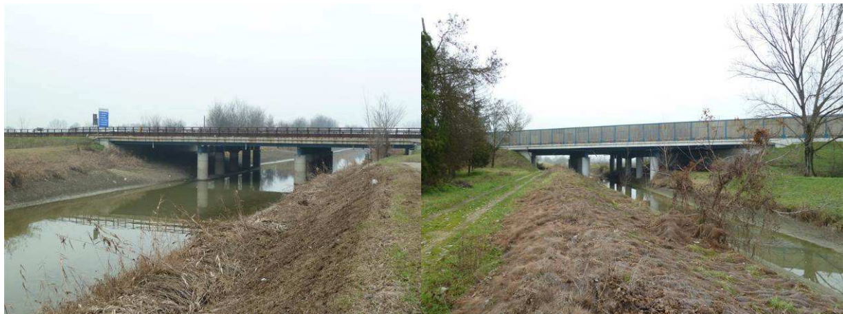
FIGURA 3.4.1-1 – OPERE AUTOSTRADALI BIOPERMEABILI: PONTE SUL CANALE FIUMA (SINISTRA) PONTE SUL CANALE NAVIGLIO (DESTRA)
