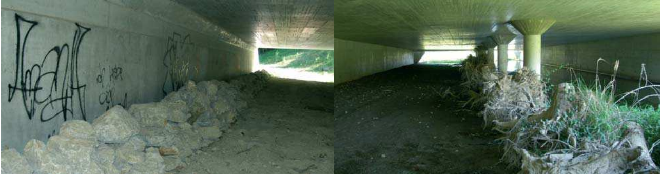
FIGURA 3.3.1-2 – ESEMPI DI ADEGUAMENTO FAUNISTICO DI MANUFATTI DI ATTRAVERSAMENTO (TRATTO DA “FAUNA SELVATICA ED INFRASTRUTTURE LINEARI” - ARPA REGIONE PIEMONTE)
