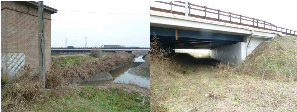
FIGURA 3.3.1-1 – OPERE AUTOSTRADALI BIO-PERMEABILI: PONTE SULLA FOSSA RASO
