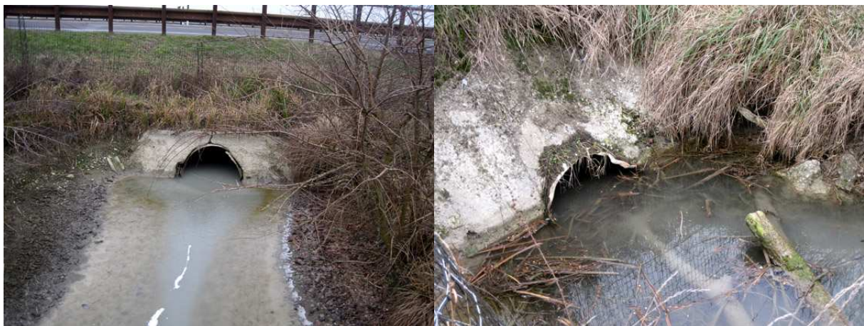
FIGURA 3.3-1 – ATTRAVERSAMENTI IDRAULICI NON IDONEI A FINI FAUNISTICI
