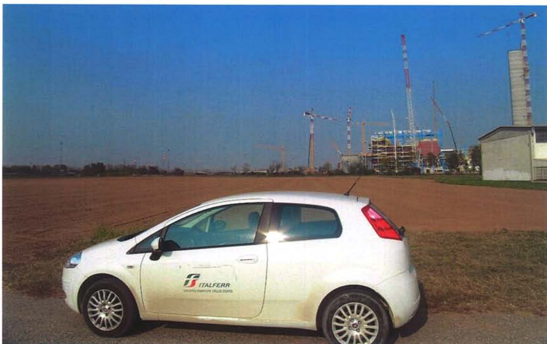
Figura 16 - vista a nord dell'area del cantiere industriale di Orbassano – nuovo termovalorizzatore in costruzione
