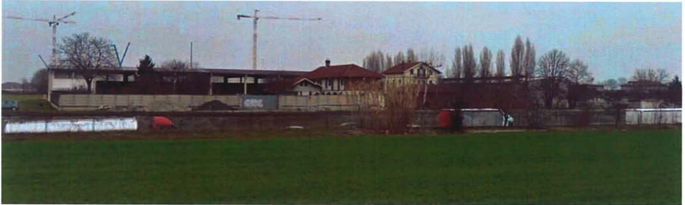
Figura 11 - vista panoramica cascina adiacente al cantiere industriale di Lose San Felice (cantiere posto a sinistra della immagine)
