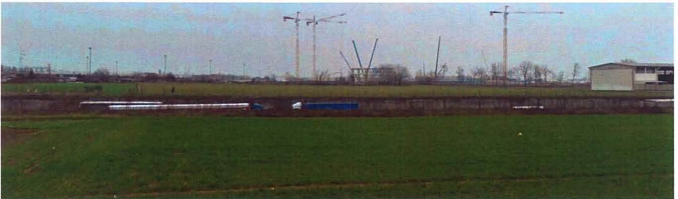
Figura 15 - Vista panoramica cantiere industriale di Orbassano
