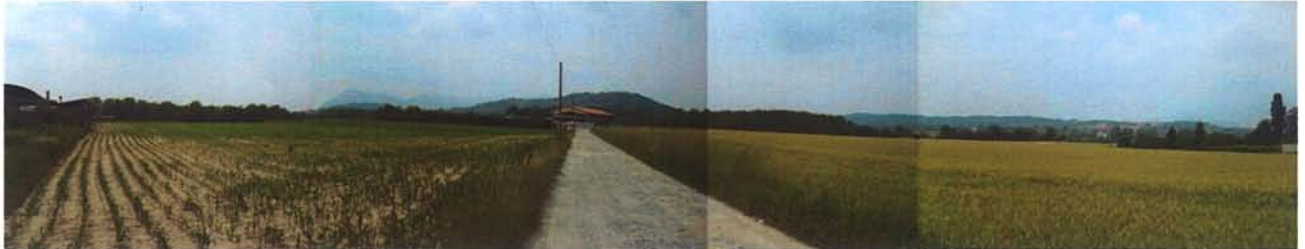
Figura 20 - Vista panoramica area di cantiere
