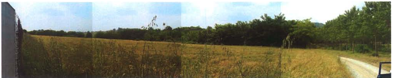
Figura 21 - Vista panoramica area di cantiere
