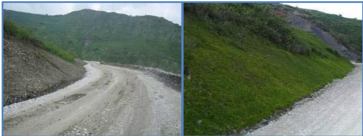
Fig. 15 - Esempio di idrosemina
