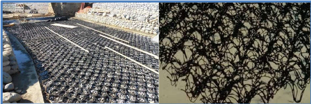
Figura 34 - Rivestimenti antierosivi con geocelle
