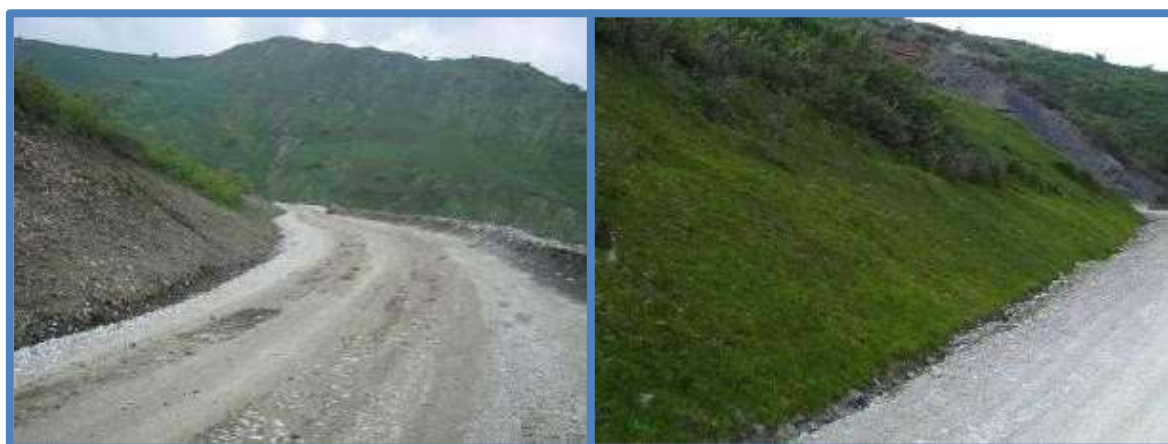
Figura 32 - Esempio di idrosemina ante e post intervento
