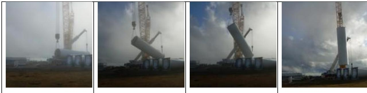
Figura 5.9 – Schema delle fasi di sollevamento dei componenti dell’aerogeneratore (Fonte sito web <http://www.windfarmbop.com/> )
