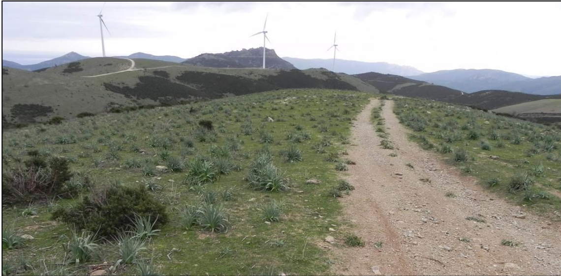
Foto 4.6 - Panoramica del sito di installazione della postazione eolica 509
