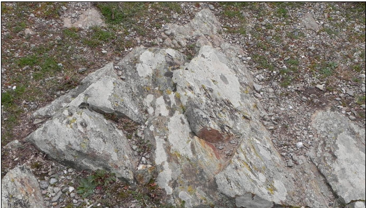
Foto 4.9 – Dettaglio della roccia d'imposta della fondazione
