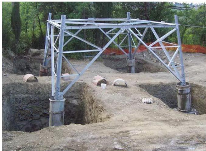
Per la realizzazione di un elettrodotto aereo l'unica fase che comporta movimenti di terra è data dall'esecuzione delle fondazioni dei sostegni.
