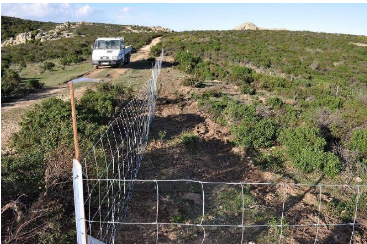
Figura 4 - Interventi di compensazione in area appositamente individuata
