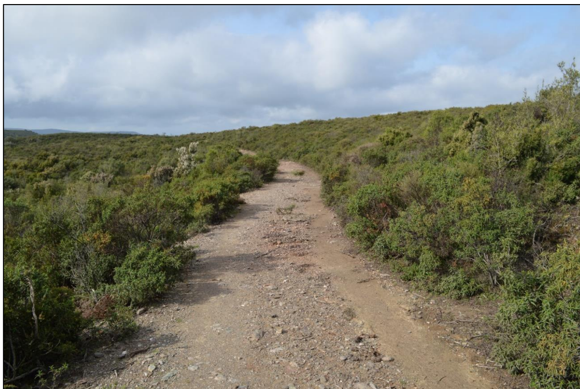
Figura 33 - Percorso cavidotto e strada sterrata per il raggiungimento della WTG 523.
