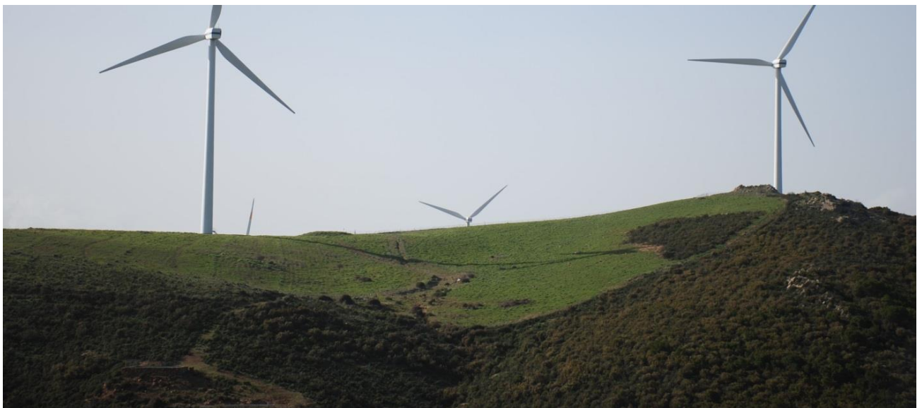
Figura 26 - panoramica di un versante soggetto ad intensi processi di ruscellamento superficiale
