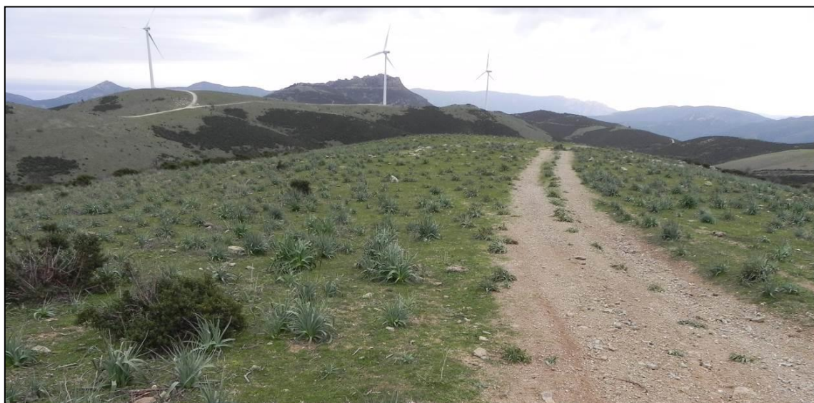
Figura 9 - Panoramica del sito di installazione della postazione eolica 509.
