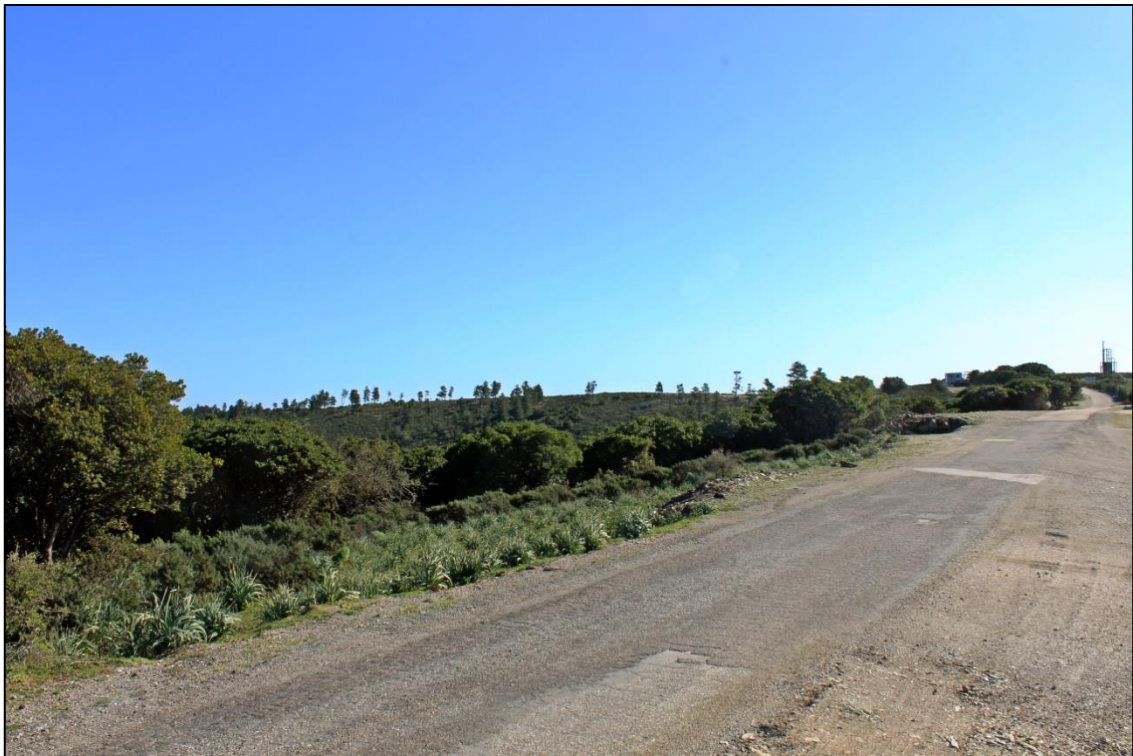
Figura 39 - Area di realizzazione del terrapieno per la futura sezione di accumulo
