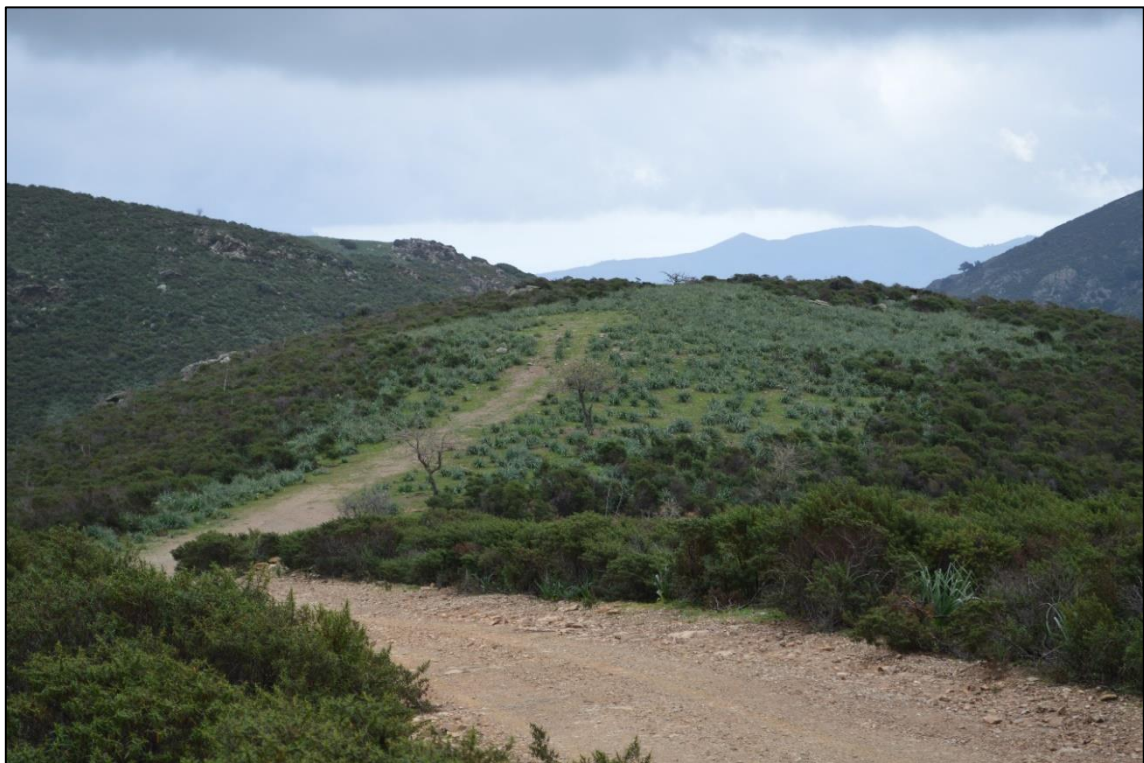
Figura 35 - Breve pista di accesso alla WTG 524 (pascolo sullo sfondo).
