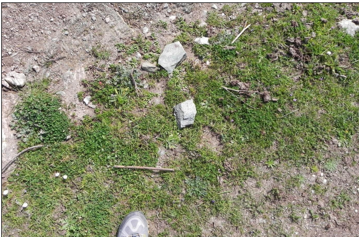
Figura 14 - Dettaglio della roccia d'imposta della fondazione.
