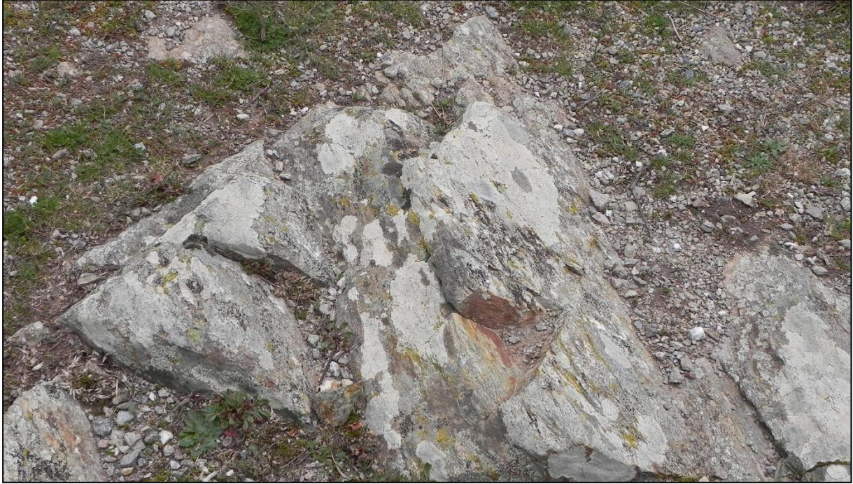
Figura 12 - Dettaglio della roccia d'imposta della fondazione.
