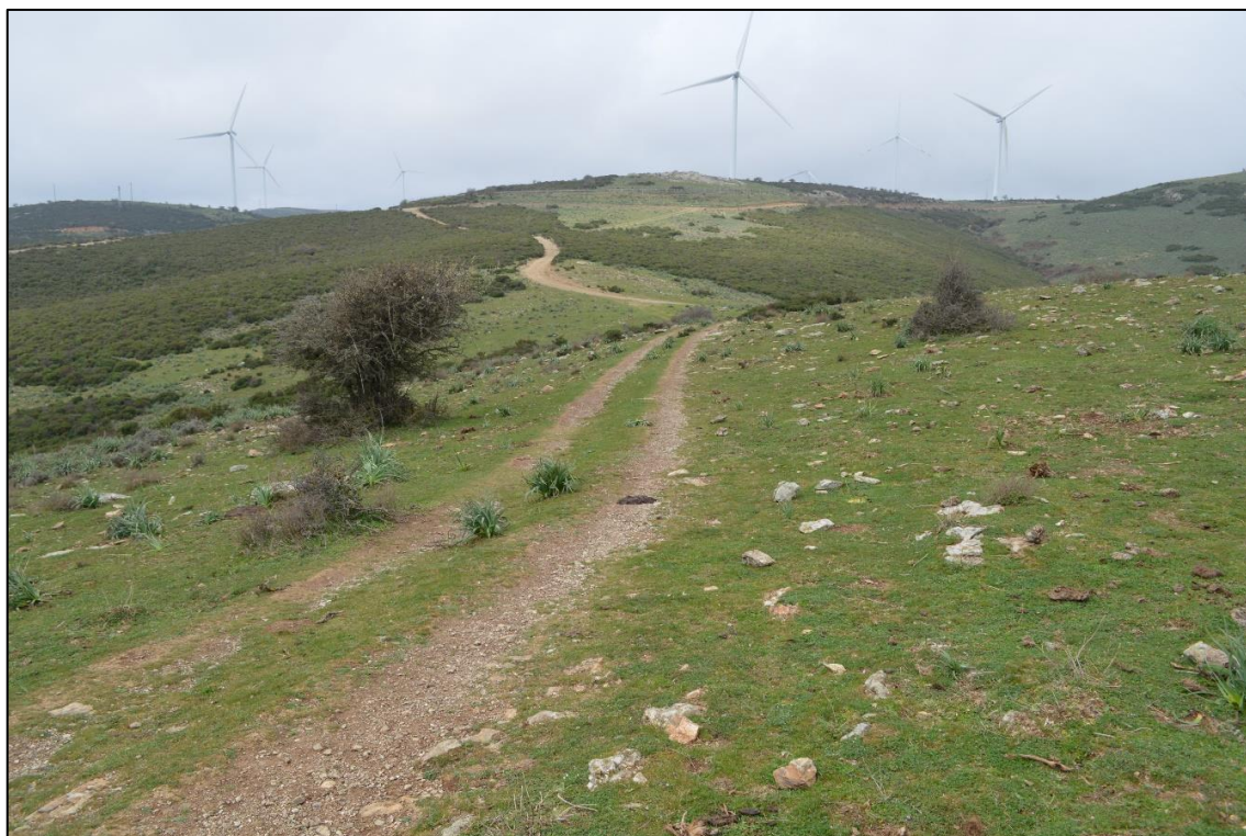
Figura 2 - Pista sterrata e percorso cavidotto di collegamento tra la WTG 518 e la SP 13.
