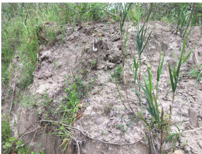
Foto 4.5 - Porzione del corpo di frana associato ad un movimento gravitativo riscontrabile nel tratto iniziale del tracciato stradale.
