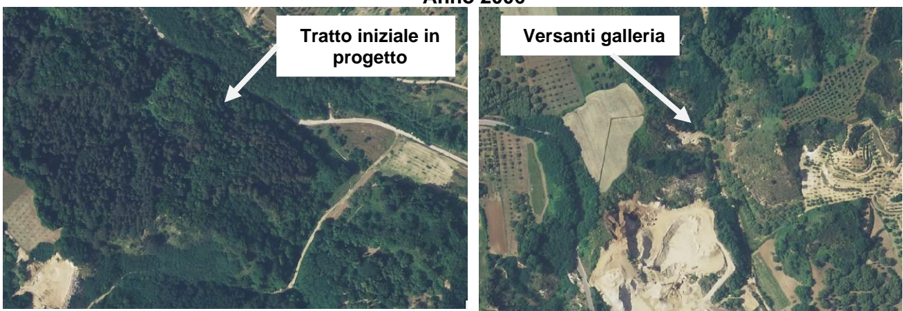
Figure 7-3 – Ortofoto riferite all'anno 2006 con indicazione di alcune tratti in progetto (Fonte Geoportale Nazionale)
