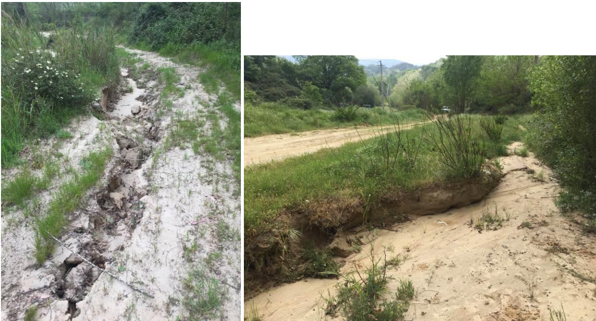
Foto 8.2 - Esempio di processi di erosione concentrata agenti lungo il tracciato in progetto
