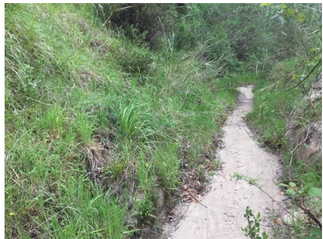
Foto 8.4 Corpo di frana di colamento visibile ai lati dell'attuale sede calpestabile e soggetta a processi erosivi
