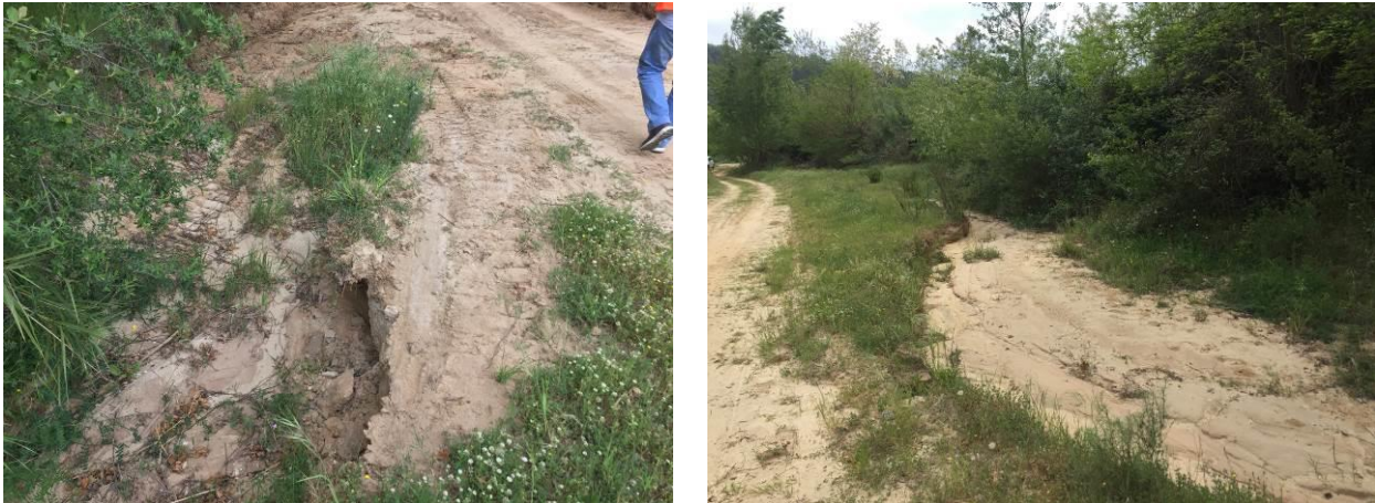
Foto 8.12 – Processi di dilavamento in atto con creazione di solchi erosivi lungo il piano calpestabile sede dell'asse stradale in progetto.
