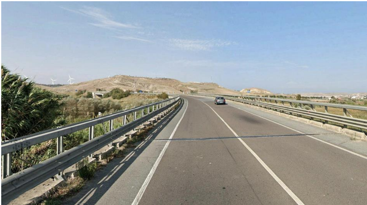
F. 03 Stato ante operam – Viadotto sul torrente Anna
