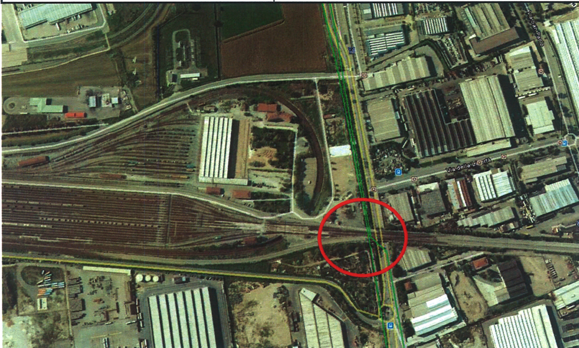
Figura 5: Scarico nel canale esistente alla pk 24+300
