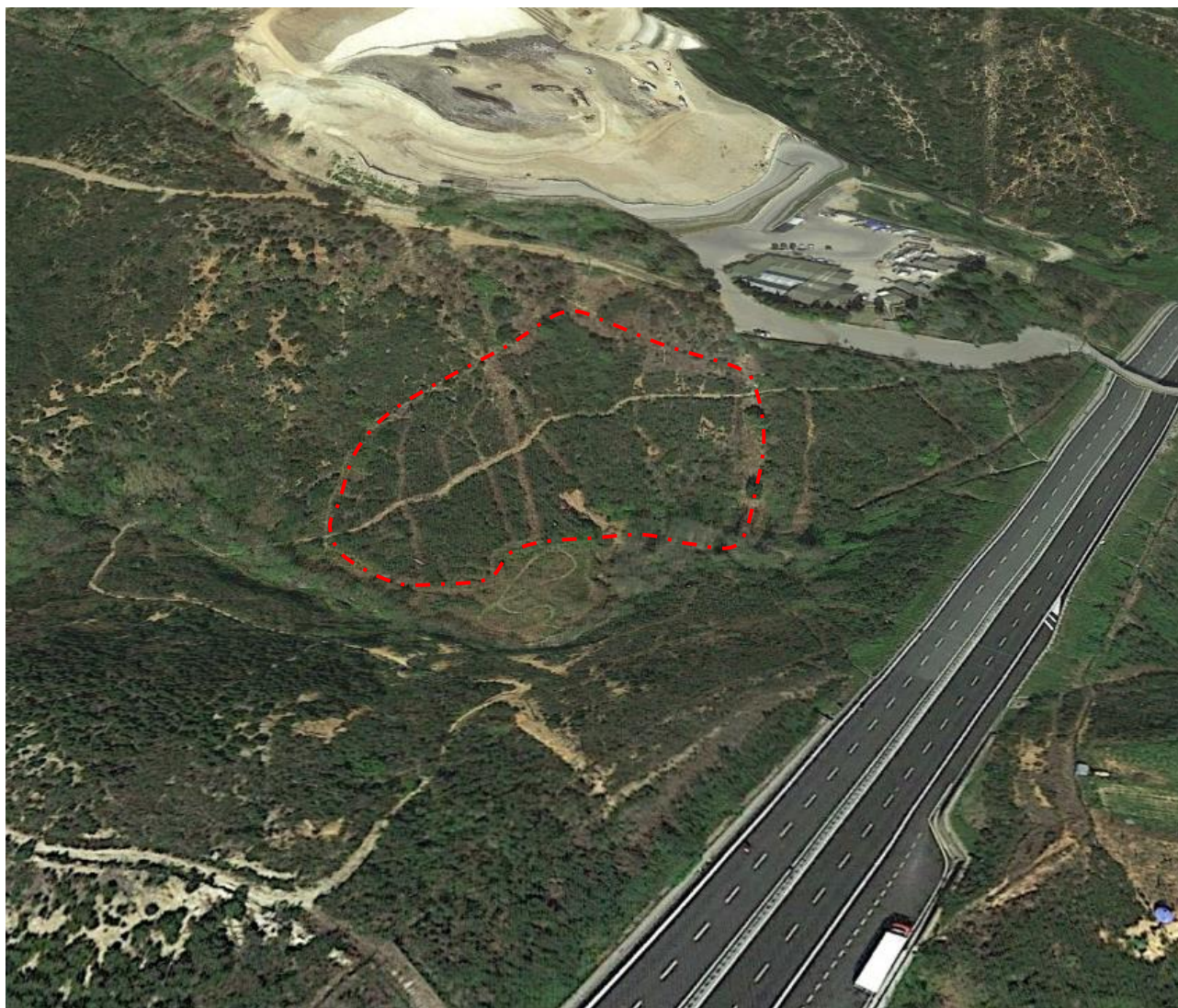
Figura 4: Immagine dell'area oggetto di indagine – in rosso l'estensione dell'area potenzialmente suscettibile al fenomeno franoso.
