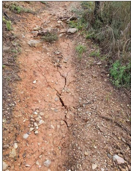
Dopo il riscontro delle fessurazioni sono state eseguite operazioni di taglio della vegetazione sul pendio lungo strisce orientate secondo la massima pendenza (già programmate per il rilievo topografico delle aree di progetto) in modo da comprendere l'entità del fenomeno.
