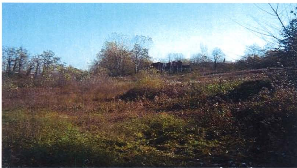
Figura 6 - Area tecnica posta al km 7+000 (vista dal confine ovest).
