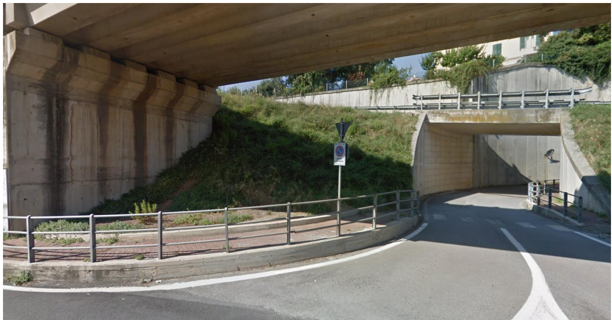
Figura 11 – Vista dell'area del cantiere operativo (Street view)
