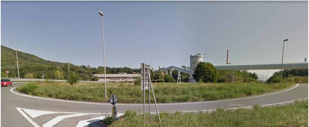
Figura 10 – Vista dell'area del cantiere operativo (Street view).
