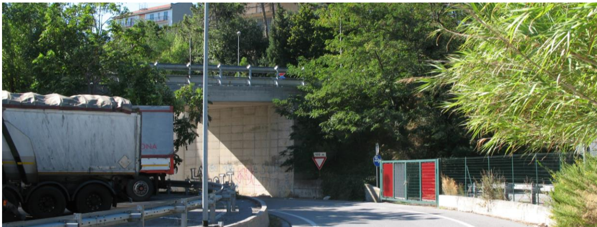
Figura 3-9 – Sottopasso in uscita dalla Motorizzazione in direzione della rotatoria
