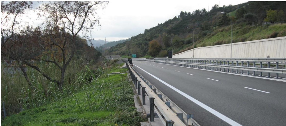
Figura 3-2 – Viste della zona di svincolo a Sud-Ovest con la Autostrada A10 "dei Fiori"
