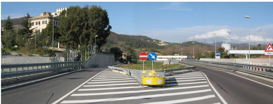
Figura 3-5 – La “Aurelia bis” ove si dipartono le rampe di collegamento con la rotatoria
