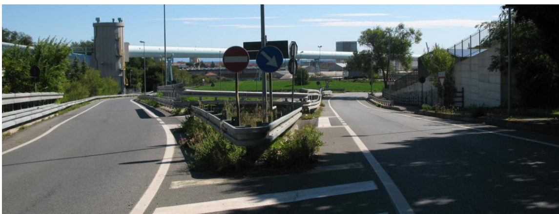
Figura 3-11 – Attuale connessione sulla rotatoria dei rami da/verso il Cimitero e la Discarica di Bossarino
