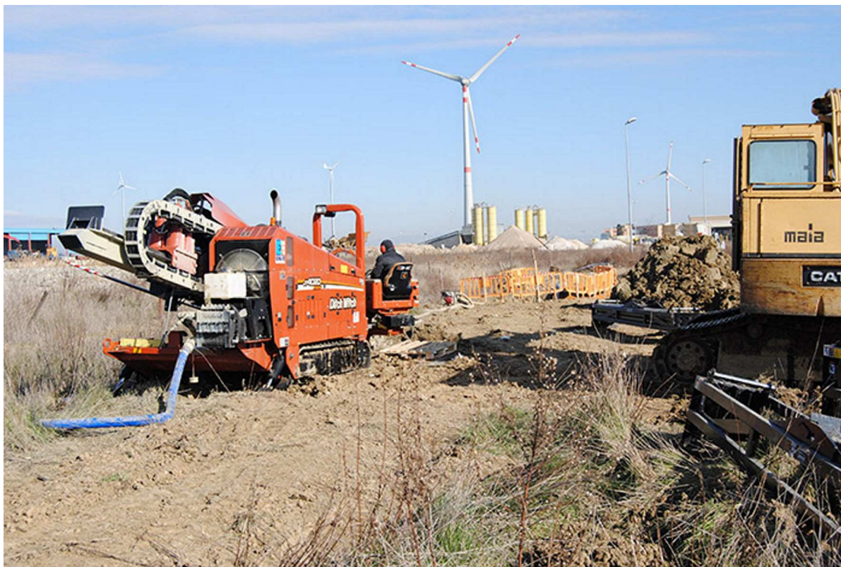
Fig.8.1. Apparecchiatura per trivellazione orizzontale controllata o teleguidata (T.O.C.)
