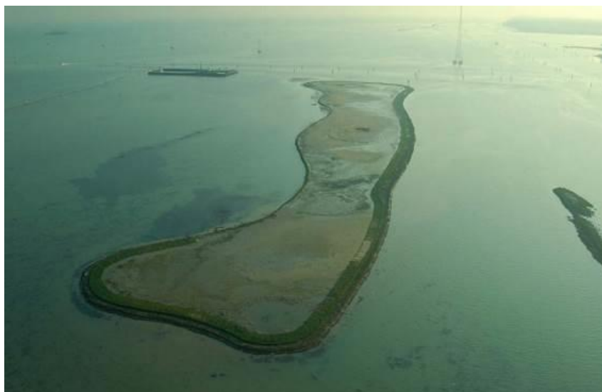
Figura 5-2: Fonte: Consorzio Venezia Nuova, barena Canale Fusina, realizzata nel 2006 lungo il canale Malamocco-Marghera. Questa struttura con funzione di canalizzazione e intercettazione è realizzata con una conformazione di burghe e materassi disposti su più livelli per proteggere il margine dal moto ondoso da vento e dalle onde e correnti prodotte dalle navi.
