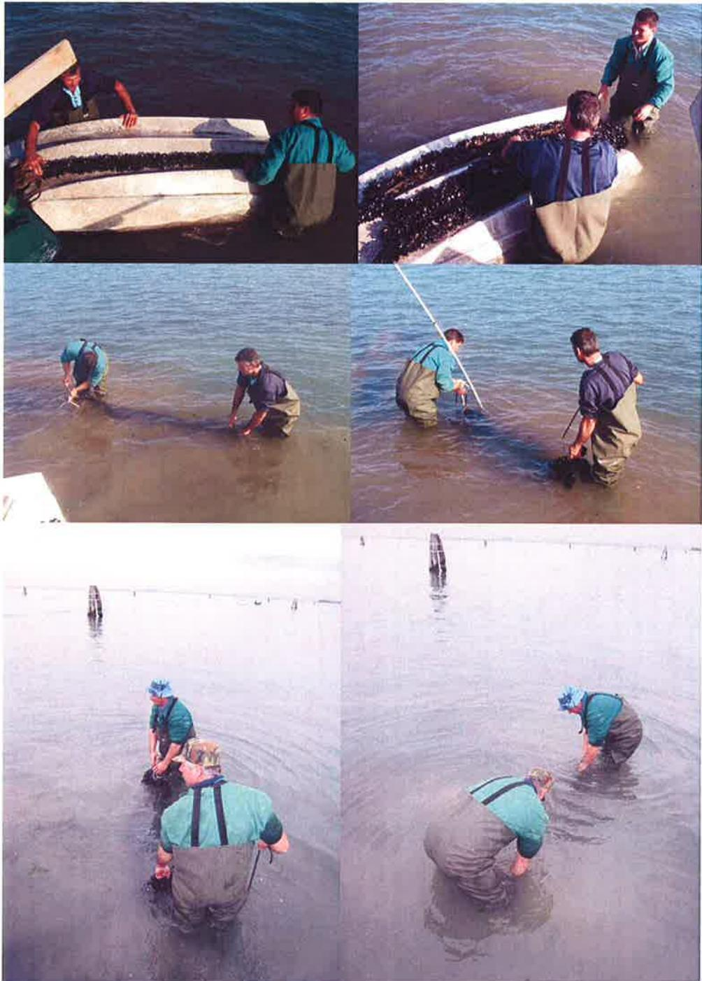
**Figura 4.5** Esempio delle fasi della messa in opera delle reste di mitili nel caso della sperimentazione del sito di Poveglia effettuata dal Magistrato alle Acque di Venezia nel 2008.
