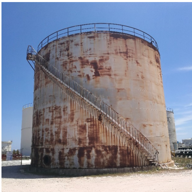
Figura 4: Vista d'insieme del serbatoio oggetto di demolizione
