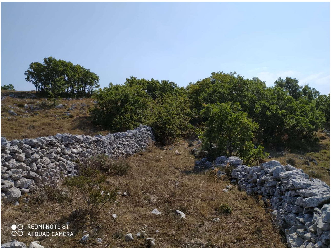
Foto 1. – muretti a secco
