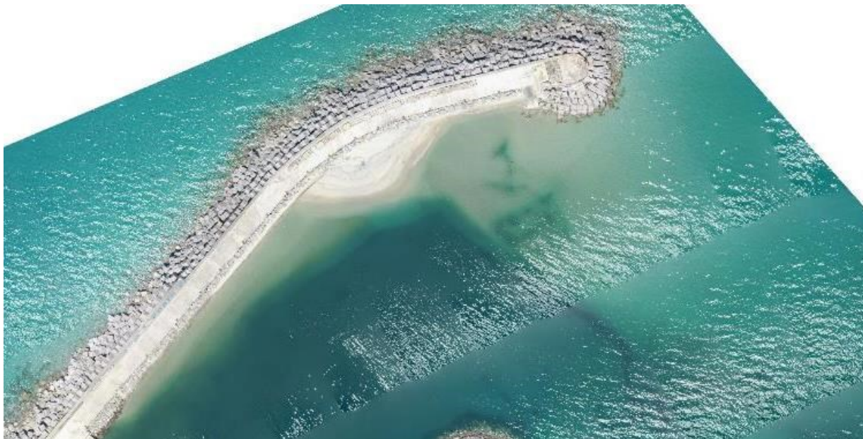
Figura 10: Accumuli di sabbia in corrispondenza dell'imboccatura – Ortofoto marzo 2020.
