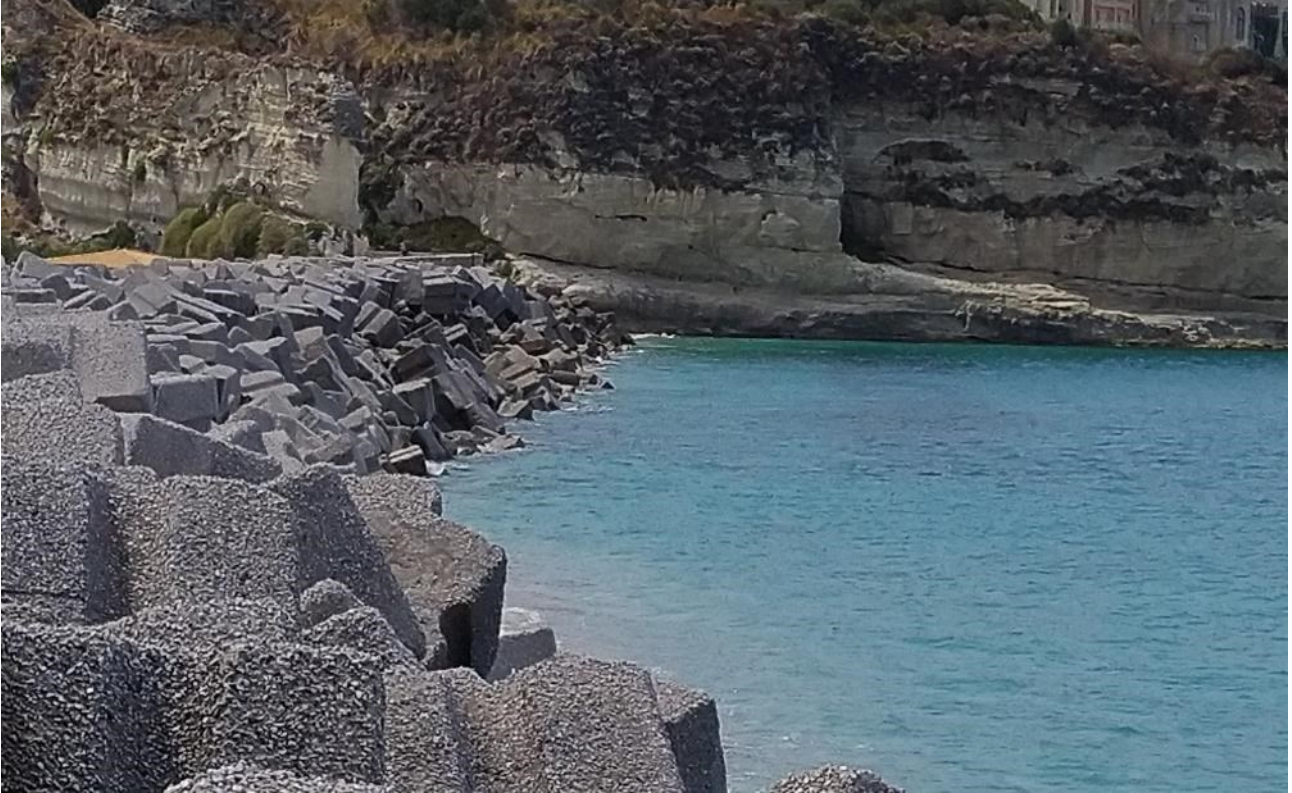
Figura 7: Vista della mantellata nel tratto ad elevata ripidità.
