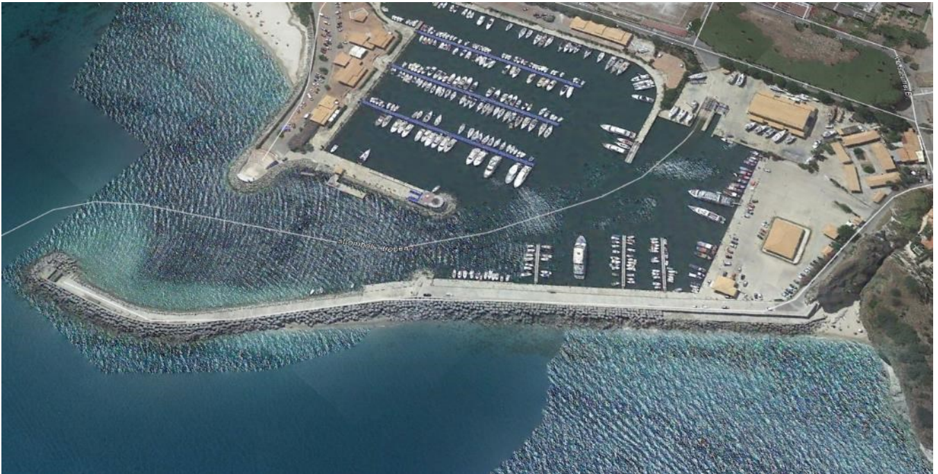
Figura 4: Vista del molo foraneo del porto di Tropea
