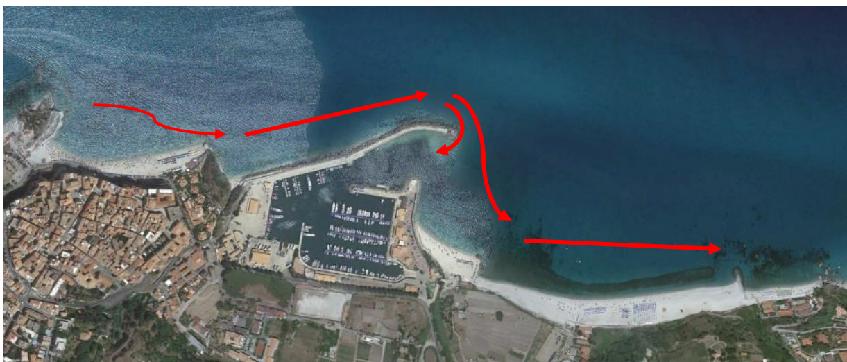
Figura 11: Schema dell'andamento prevalente delle correnti indotte dal moto ondoso
