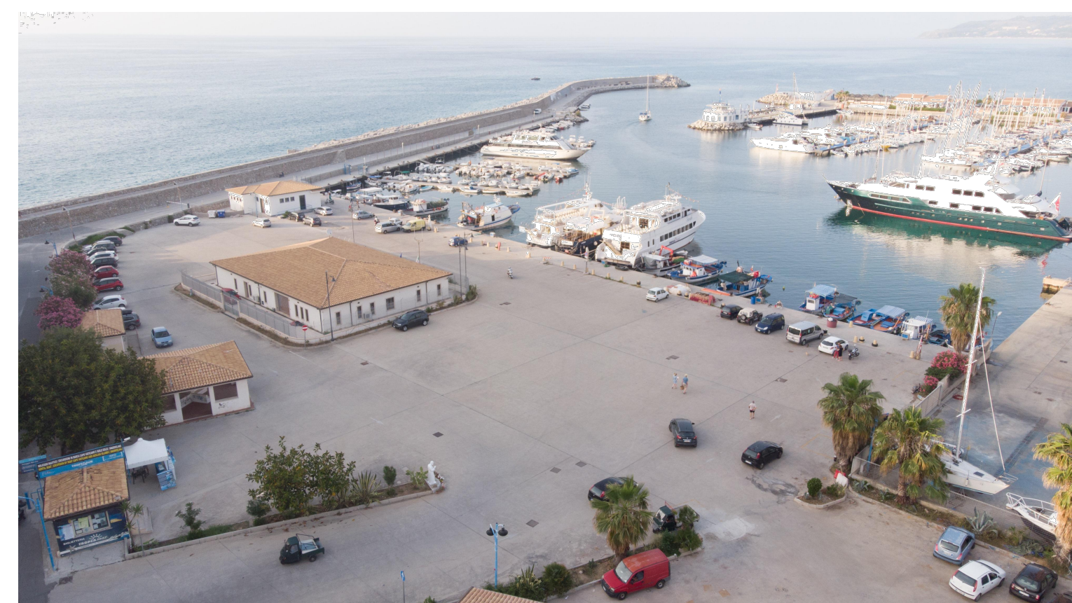
Foto 2 - l'area d'intervento da Ovest
