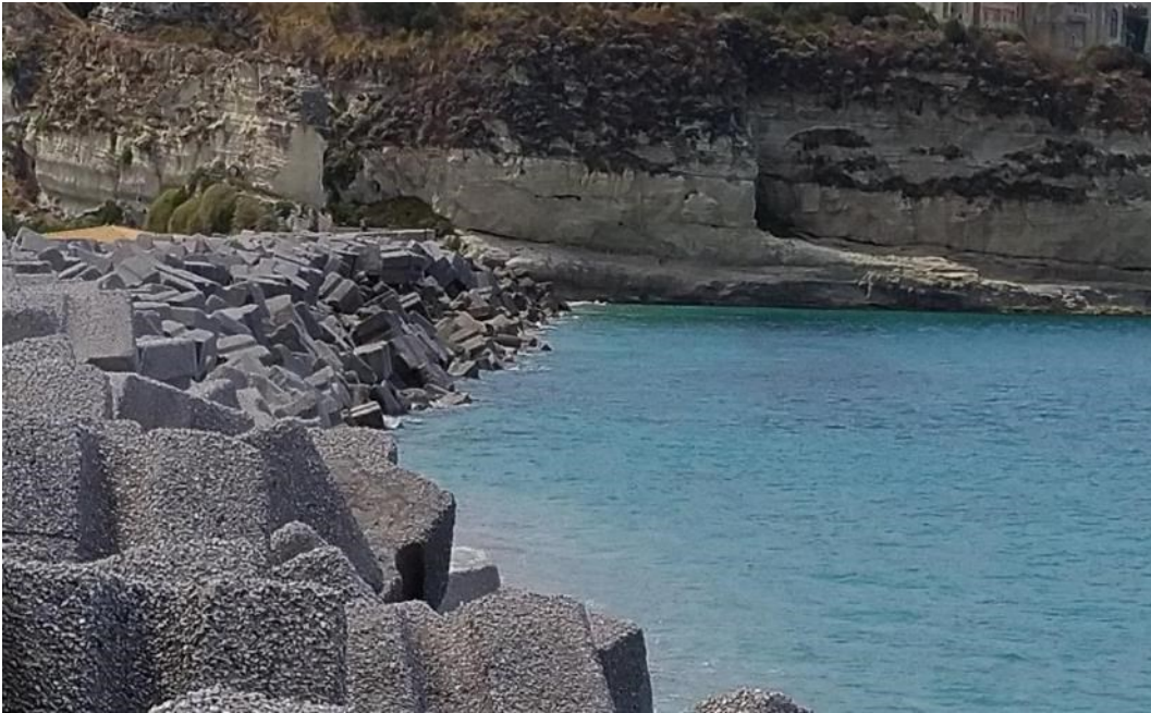
Figura 8: Vista della mantellata nel tratto ad elevata ripidità.
