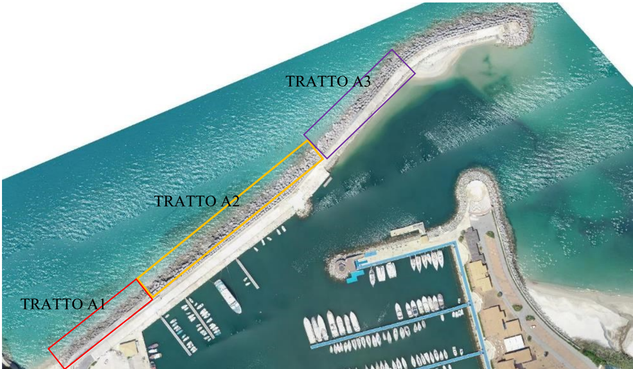
Figura 10: Vista aerea del molo foraneo rilevata dal drone nel marzo 20202, con individuazione dei tratti soggetti a diversi problemi strutturali.
