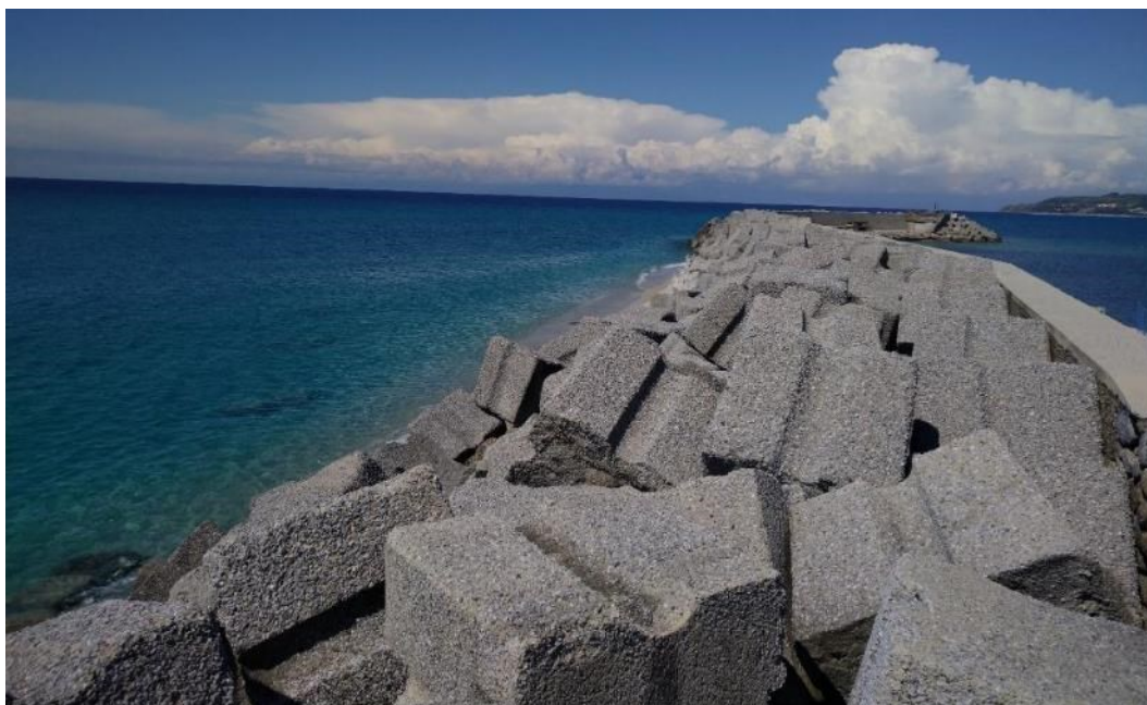
Figura 7: Vista del molo foraneo e della mantellata di protezione- tratto finale.
