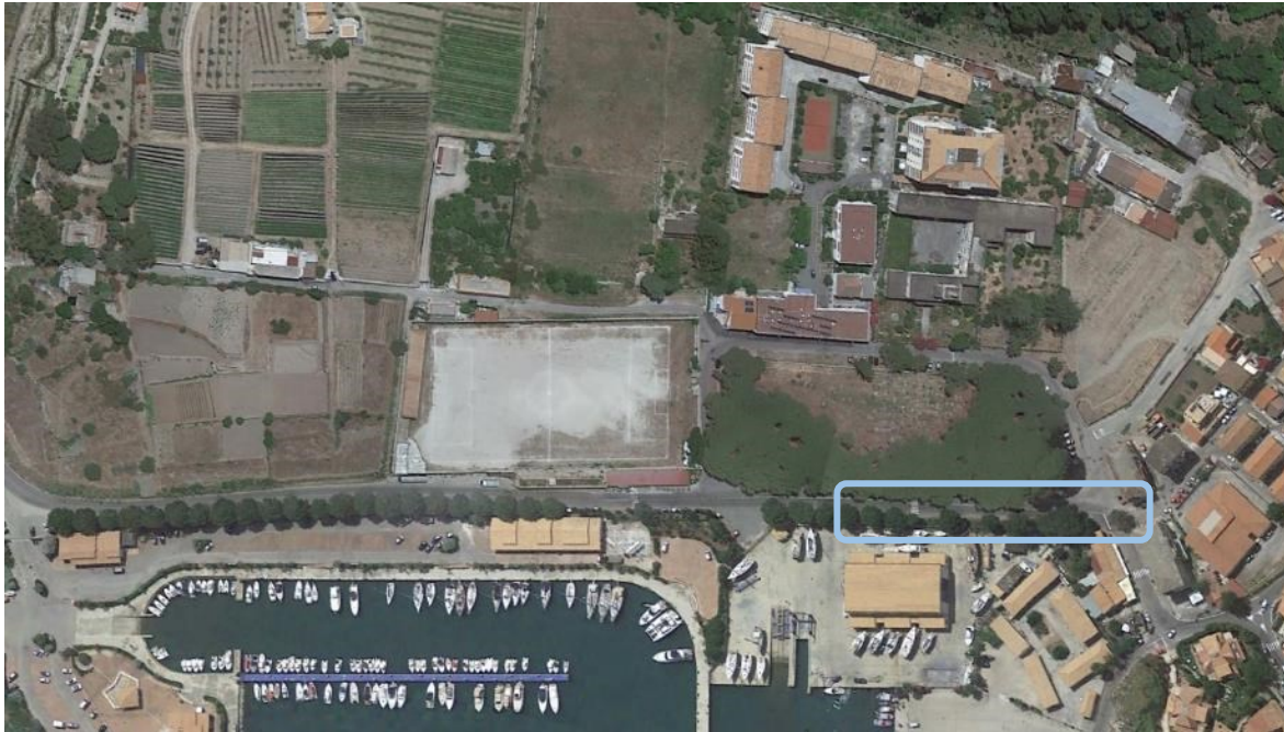
Figura17: Ubicazione dell'area frequentemente soggetta ad allagamento.
