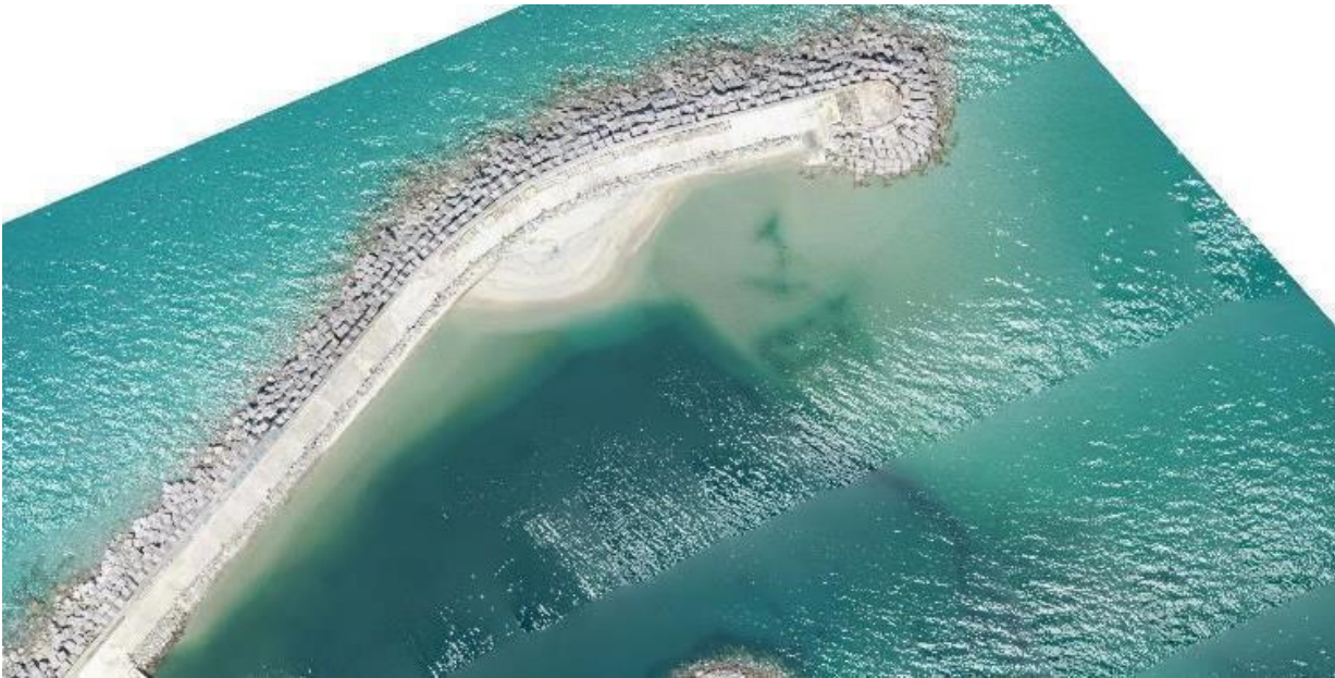
Figura 11: Accumuli di sabbia in corrispondenza dell'imboccatura – Ortofoto marzo 2020.
