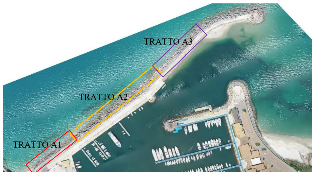
Figura 6: Vista aerea del molo foraneo rilevata dal drone nel marzo 20202, con individuazione dei tratti soggetti a diversi problemi strutturali.
