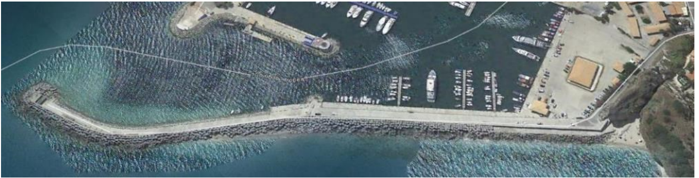
Figura 1: Vista del molo foraneo del porto di Tropea
