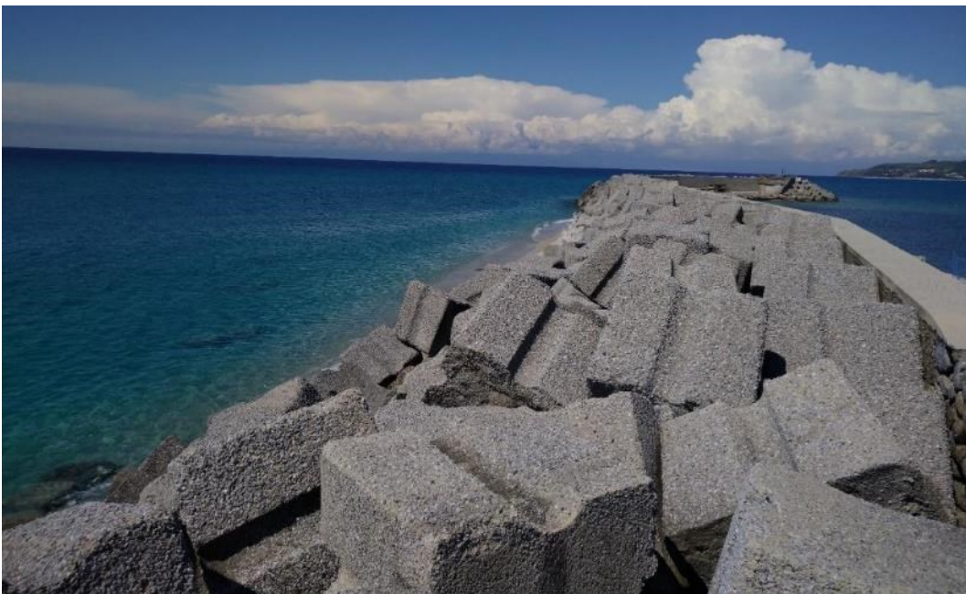
Figura 3: Vista del molo foraneo e della mantellata di protezione- tratto finale.
