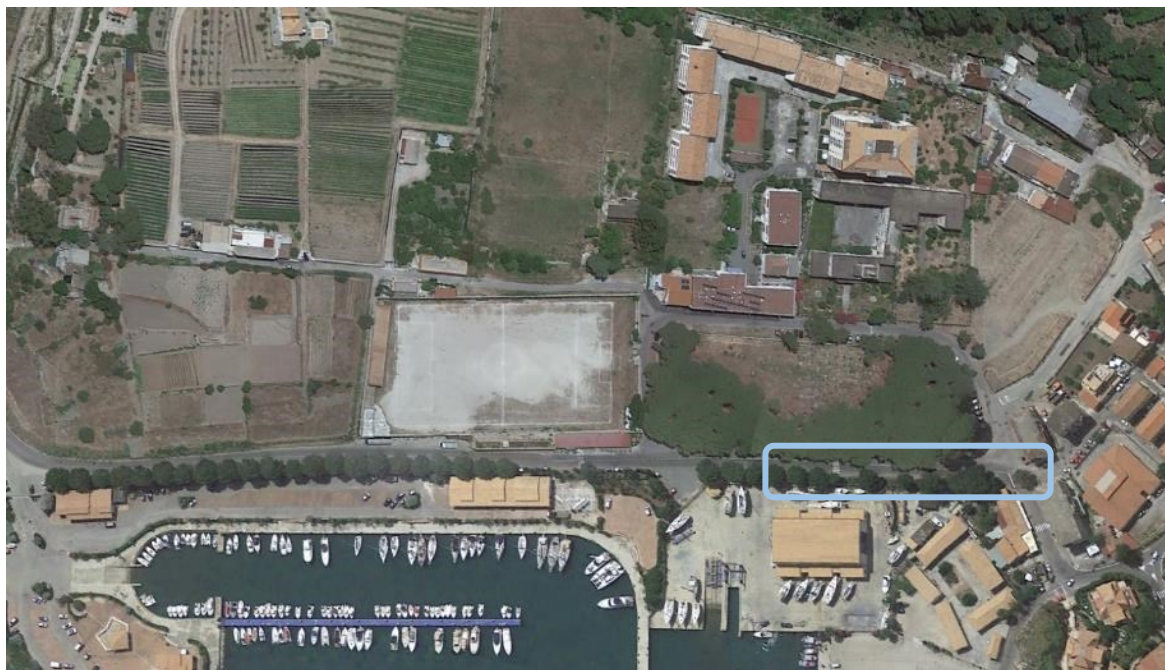
Figura 11: Ubicazione dell'area frequentemente soggetta ad allagamento.
