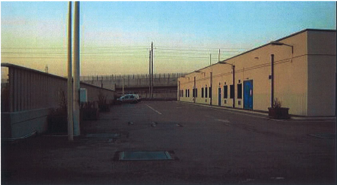
Figura 10 - Stato attuale della linea ferroviaria nel comune di Settimo Torinese, direzione est, dove è discontinuo il fronte delle barriere.
