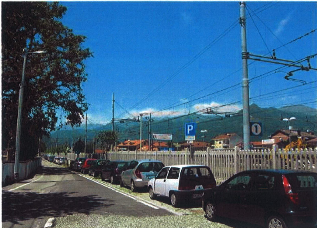
Figura 8 - Stato attuale della linea ferroviaria nel centro abitato di Avigliana, direzione ovest
