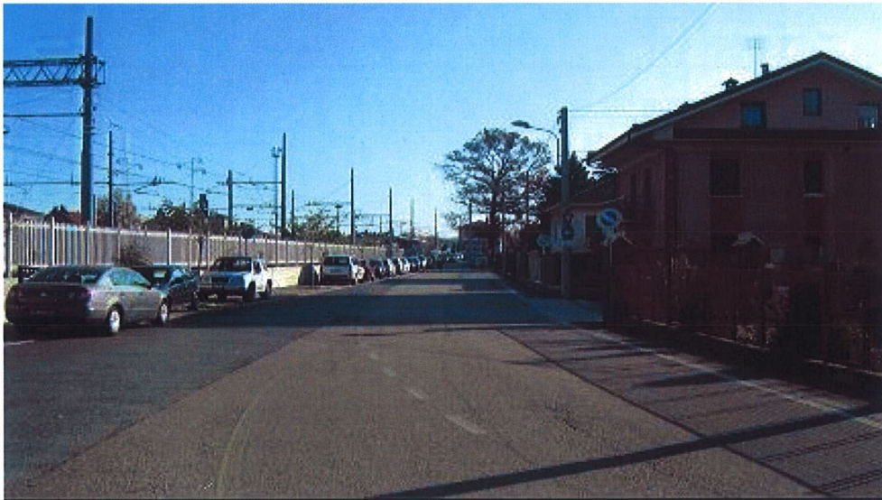
Figura 6 – Stato attuale della linea ferroviaria dal centro abitato di Avigliana, direzione est.
