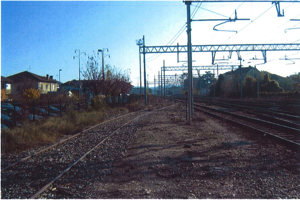
Figura 7 - Stato attuale della linea ferroviaria dal centro abitato di Avigliana, direzione est.
