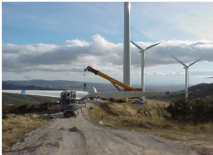
**Figura 4-5: Ingombro del rotore a terra**
