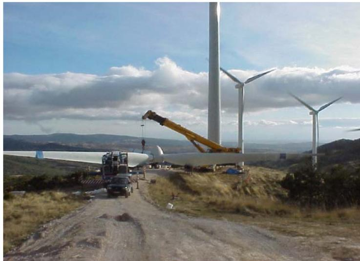
Figura 4-5: Ingombro del rotore a terra
