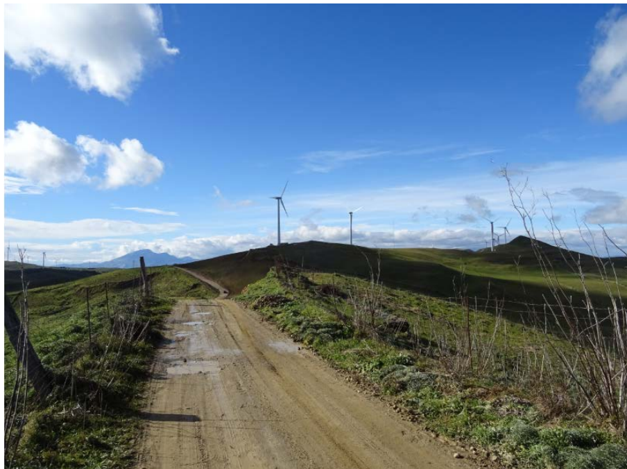
Figura 3-9: Vista impianto esistente da est
