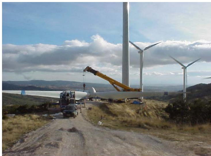
Figura 3-5: Ingombro del rotore a terra
