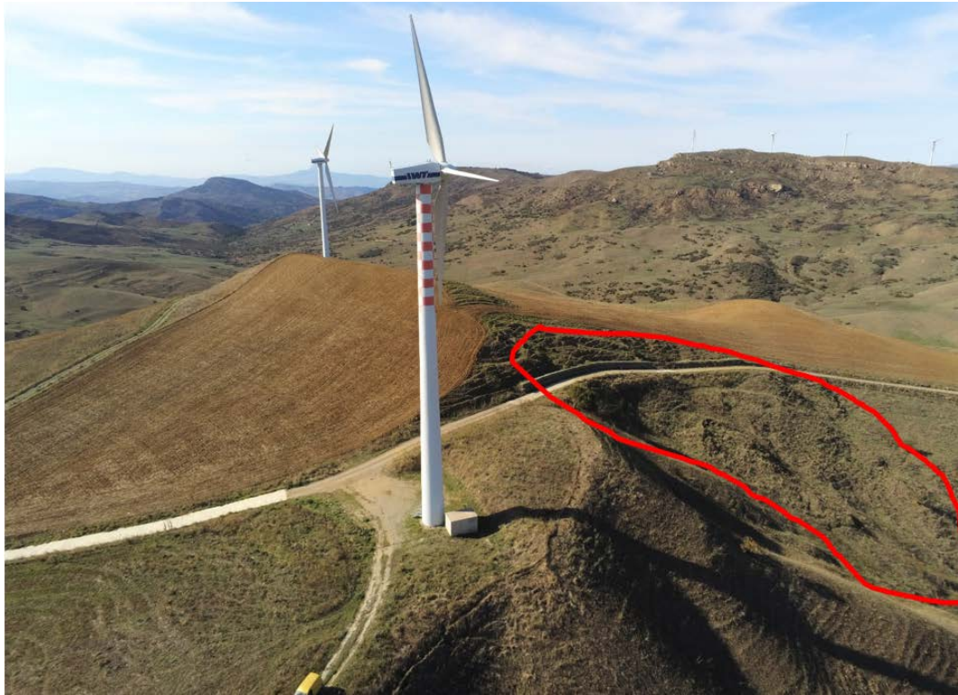
Figura 4-15: Frana in prossimità di SB05
