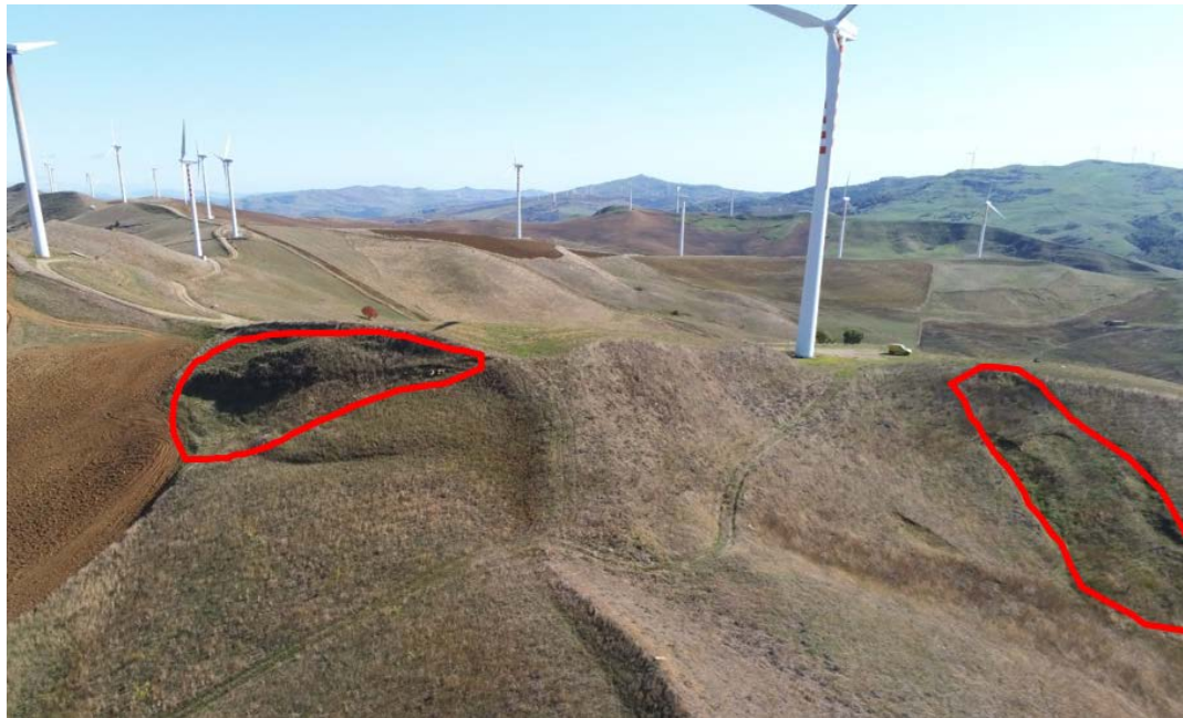
Figura 4-14: Colamenti a valle dell'aerogeneratore
