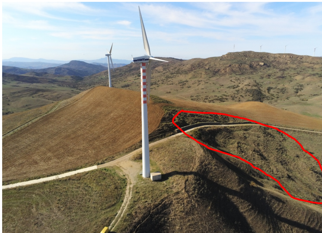
Figura 4-6: Frana in prossimità di SB05
