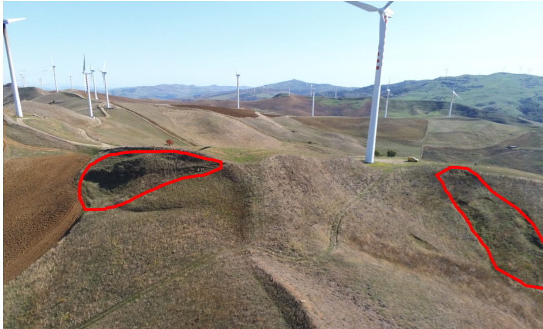
Figura 4-5: Colamenti a valle dell'aerogeneratore
