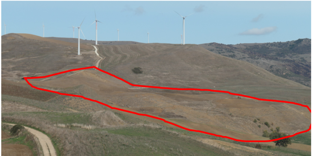
Figura 4-3: Area della recente frana
