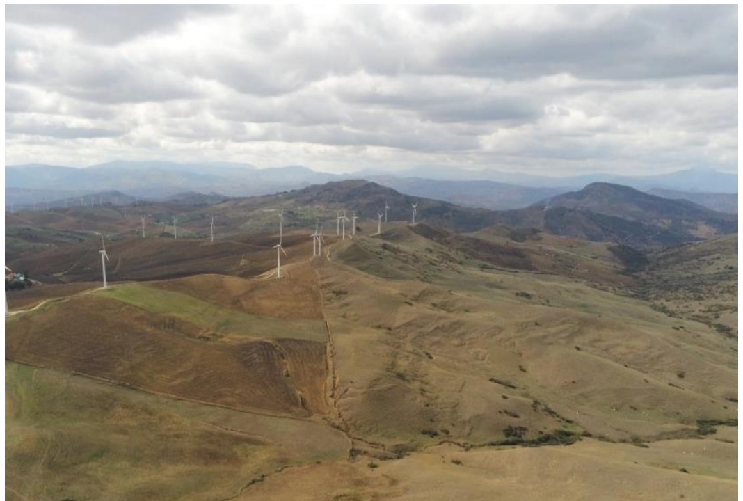
Visione da est verso ovest verso SB04-03-02-01
