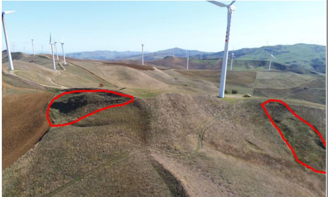
Vista al di sotto di SB01
