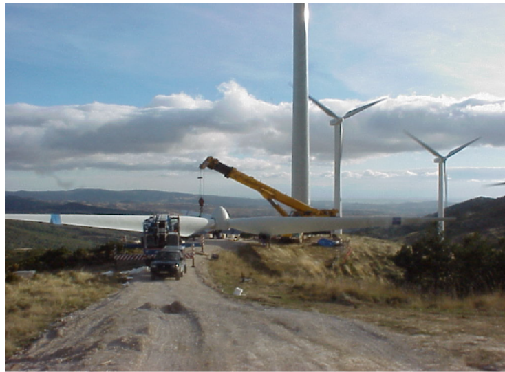
Figura 2-5: Ingombro del rotore a terra
