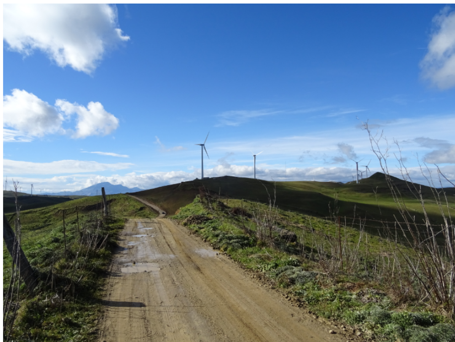
Figura 2-9: Vista impianto esistente da est
