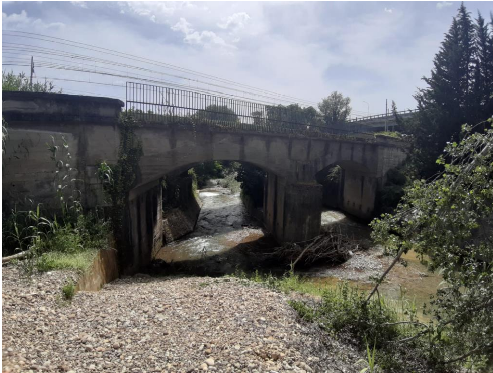
Figura 12 – Ponte ferroviario in disuso sul Fiume Picentino.
