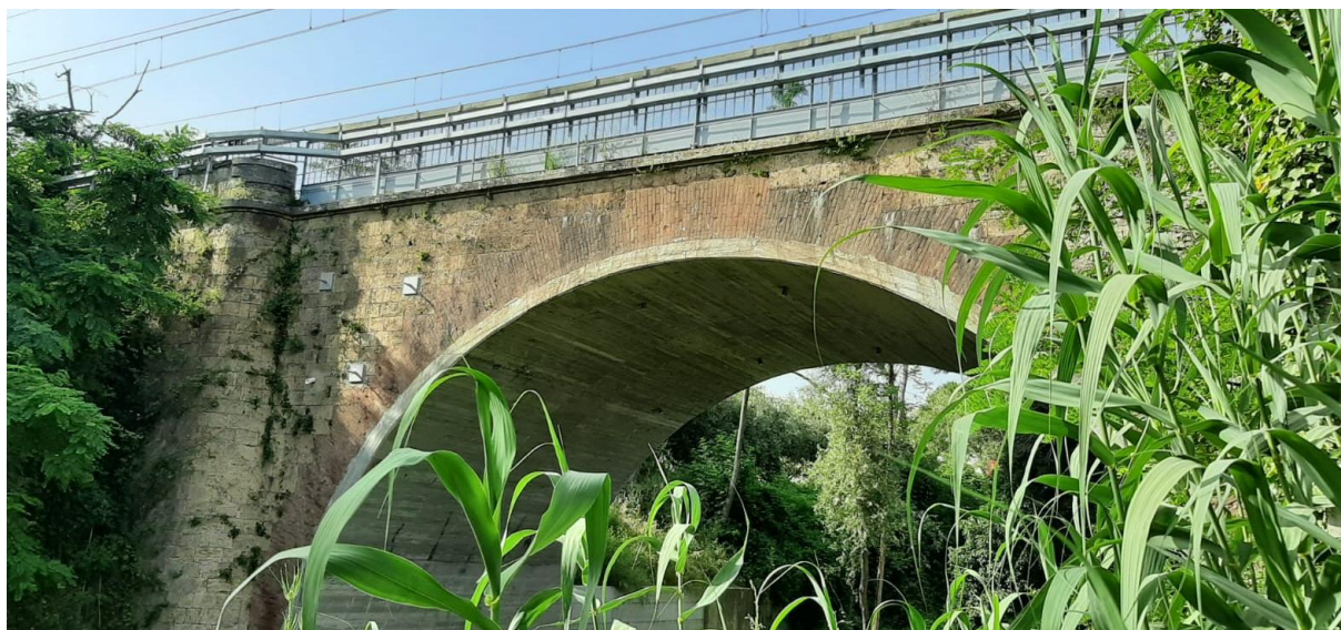
Figura 17 – Opera ferroviaria esistente (linea FS Salerno - Battipaglia) sul Torrente Asa.
