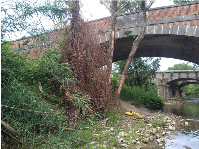
Figura 14 – Fiume Picentino: ponte stradale di via Roma/via Picentino, a monte dei due ponti ferroviari.
