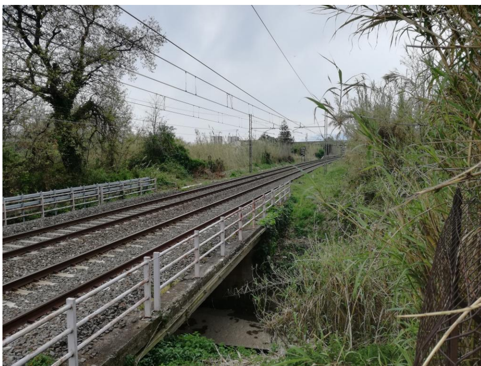
Figura 9 – Opera ferroviaria esistente (linea FS Salerno - Battipaglia) sul Torrente Fuorni.
