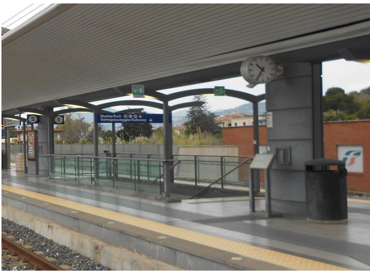
Stazione di Arechi: Banchina, pensilina e parapetto
