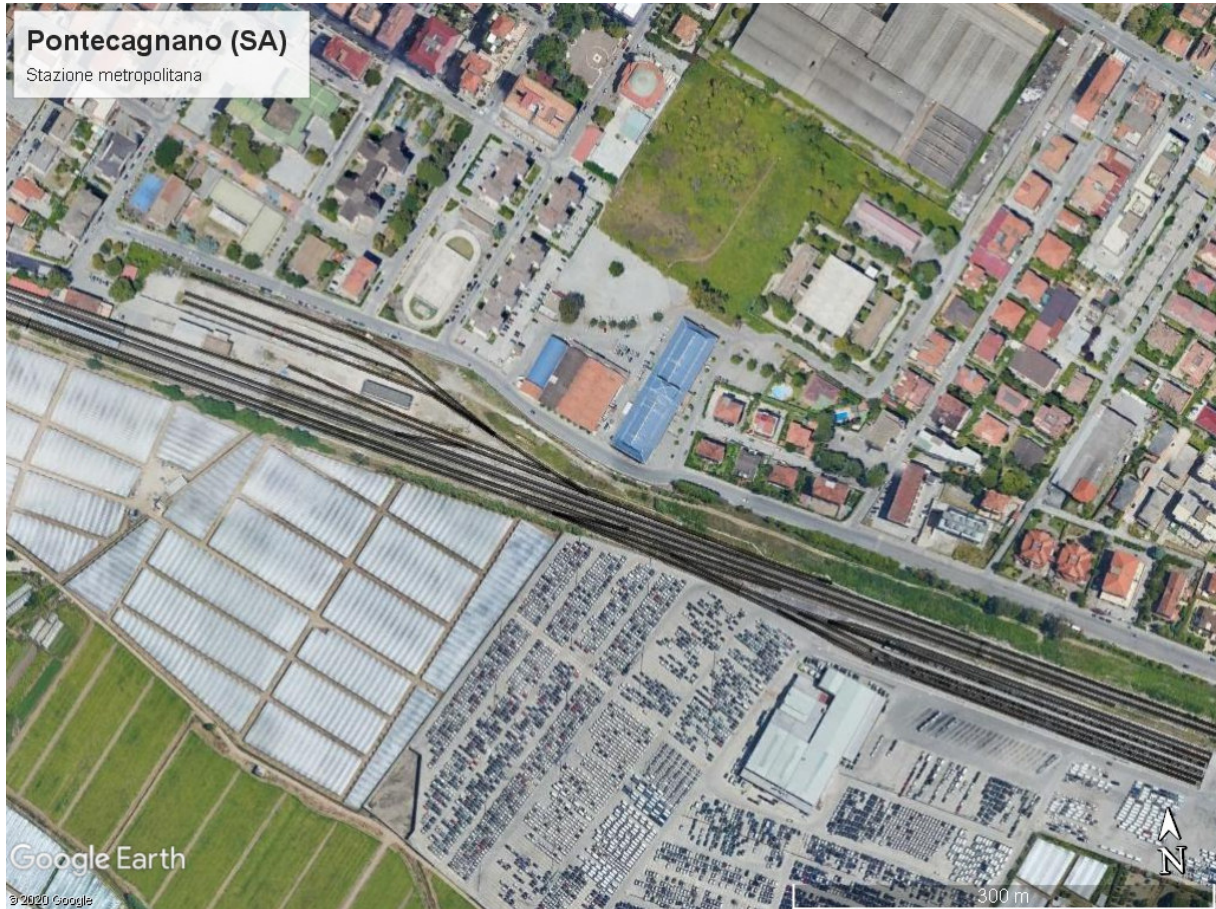
Figura 4 - Vista aerea stazione Pontecagnano (SA) from Google Earth
