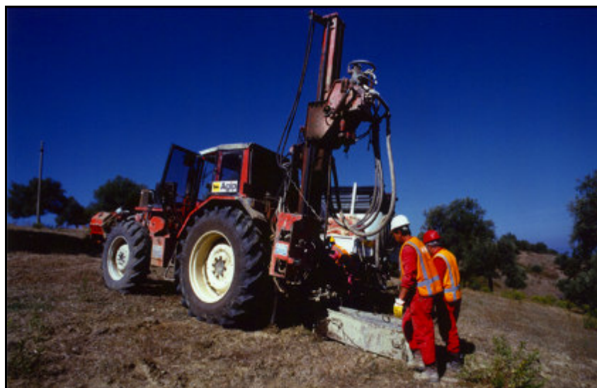
Figura 1.3-7: perforatrice “convenzionale” su trattore 4x4 operante con fango bentonitico
