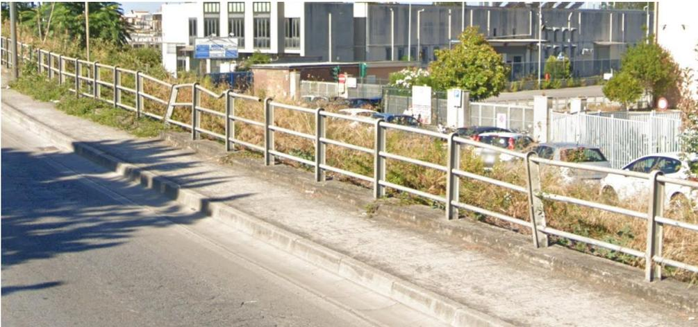
In questo tratto, oltre alle barriere di sicurezza su marciapiede è prevista l'installazione della rete di protezione con altezza pari almeno a 2.00m (come riportato nel D.M. 05/11/2001).
