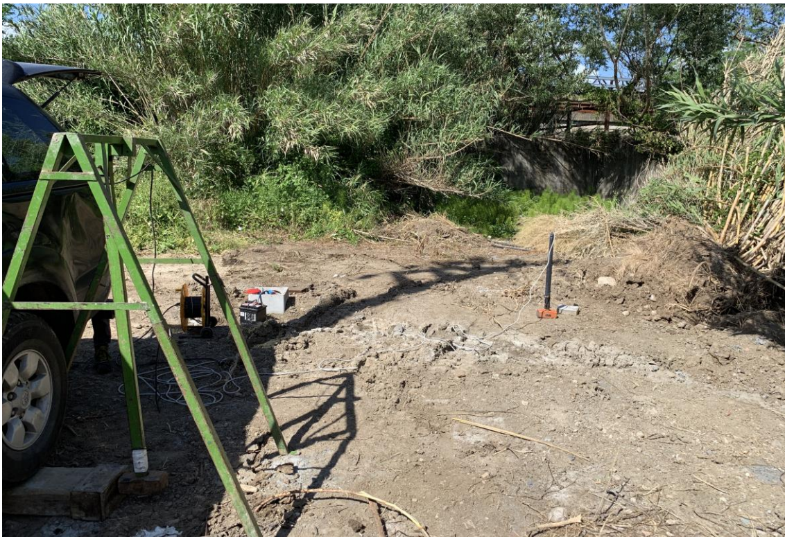
Figura 98: foto relativa all'esecuzione della prova down-hole BH 22.
