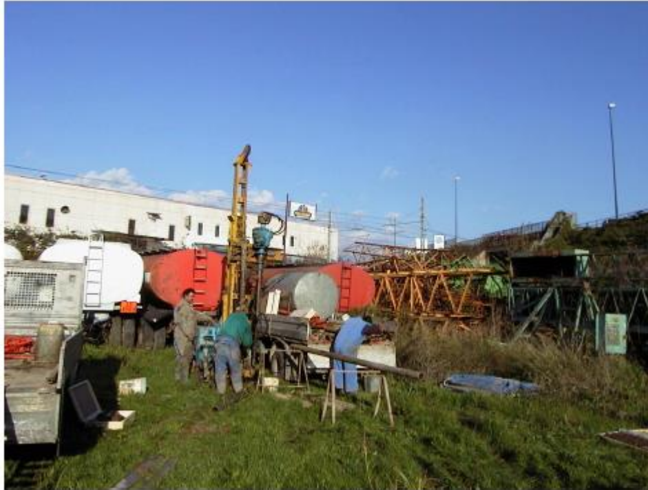
SONDAGGIO 2 – UBICAZIONE PUNTO D'INDAGINE
