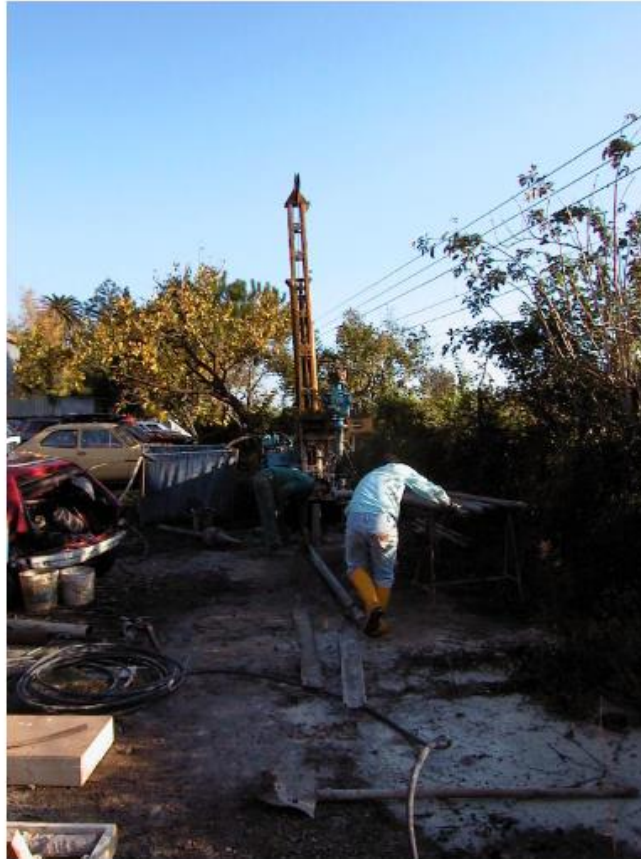
SONDAGGIO 1 – UBICAZIONE PUNTO D'INDAGINE
