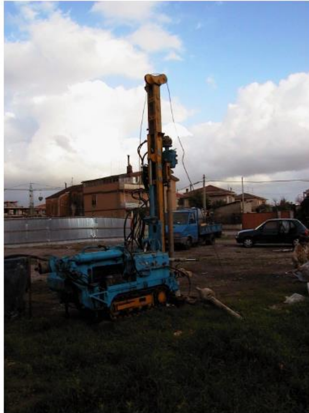
SONDAGGIO 5 – UBICAZIONE PUNTO D'INDAGINE
