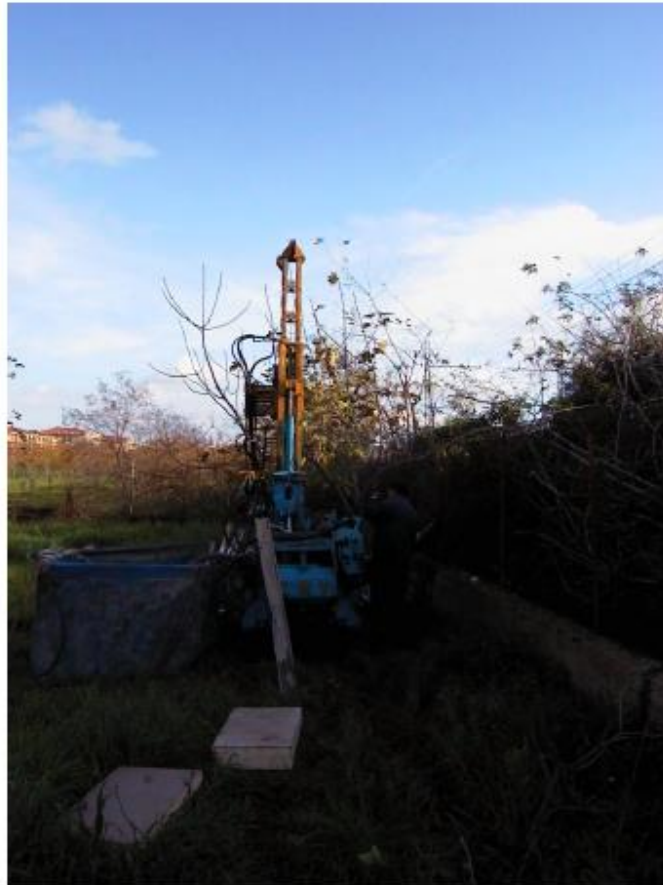
SONDAGGIO 6 – UBICAZIONE PUNTO D'INDAGINE
