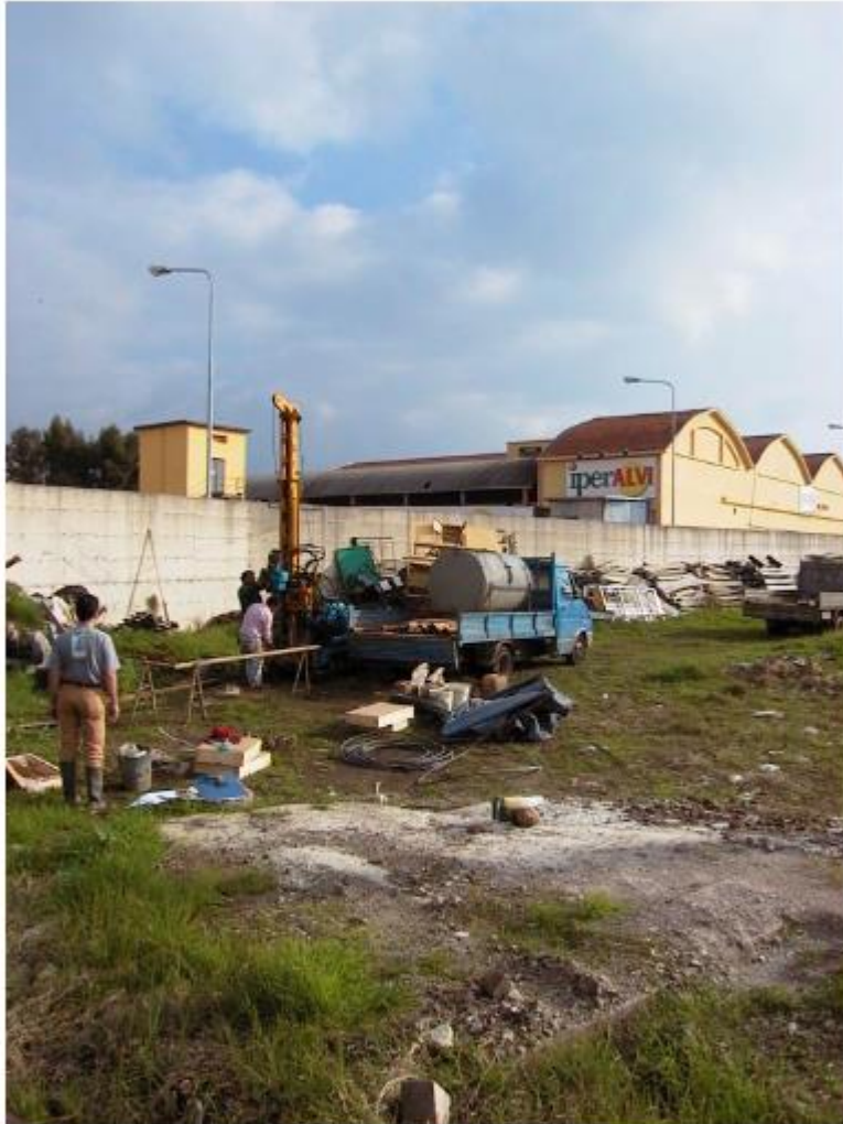
SONDAGGIO 4 – UBICAZIONE PUNTO D'INDAGINE
