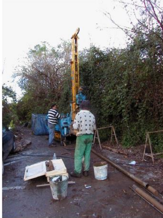
SONDAGGIO 3 – UBICAZIONE PUNTO D'INDAGINE
